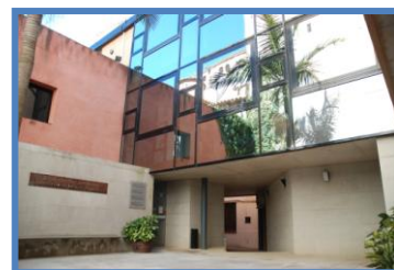
Figura 18. Imatge exterior de l'Arxiu Municipal (2012)
