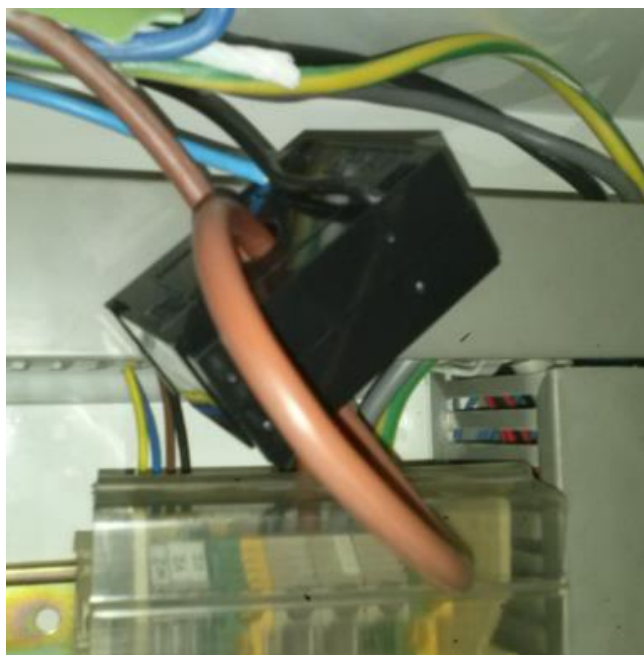
Figura 2.3 Muntatge del transformador
