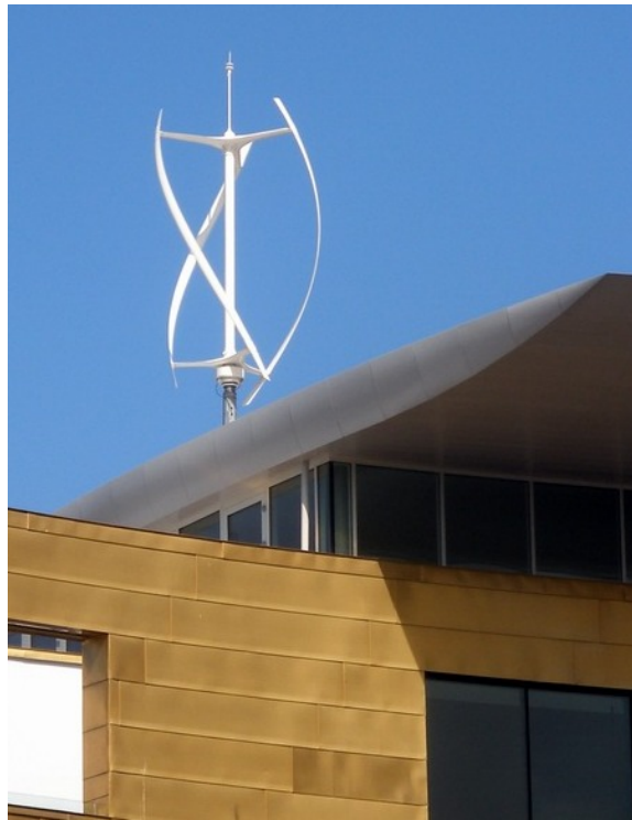
Figura 2.14: Generador minieòlic de 6,5kW a Oxford, Anglaterra. [20]
