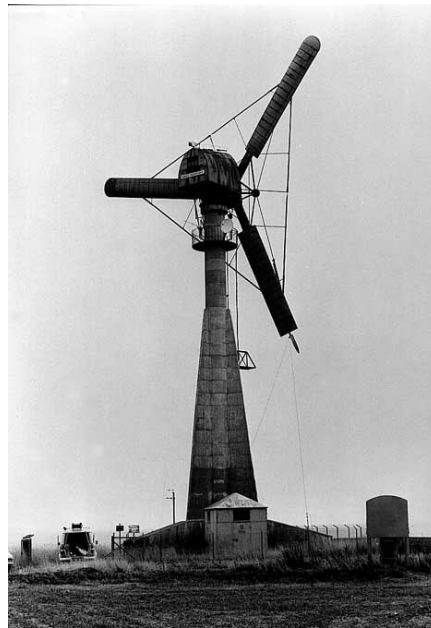
Figura 2.4: Primer aerogenerador de corrent alterna, construït per Johannes Juul. [21]
