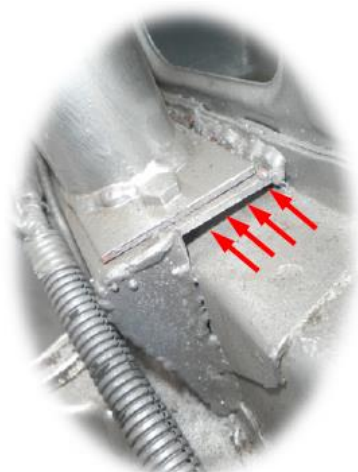
Figura A.5: Placa de reforç no soldada completament
