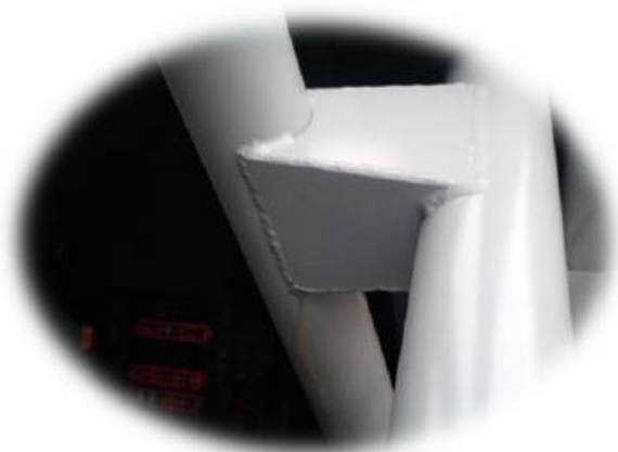
Figura A.3: Unions en el cas de barres creuades
