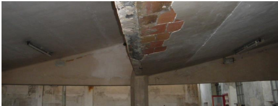
Figura: vista inferior forjat coberta dents de serra Font: Pròpia
