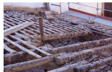
Títol: Rehabilitació coberta, nau.3 Burés
