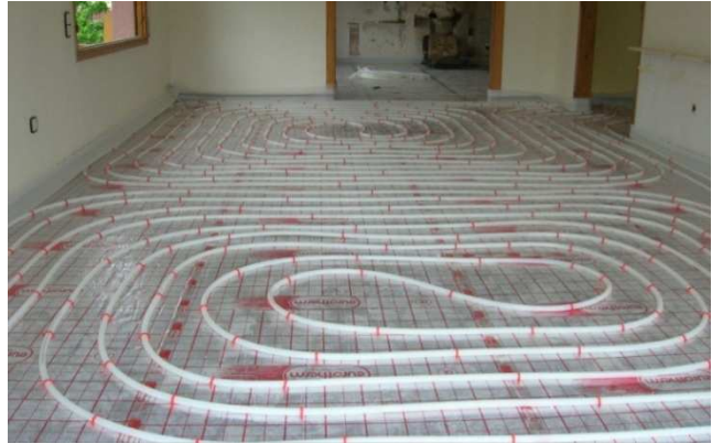
Col·locació sistema de tubs terra radiant. Font: imatges Google.
