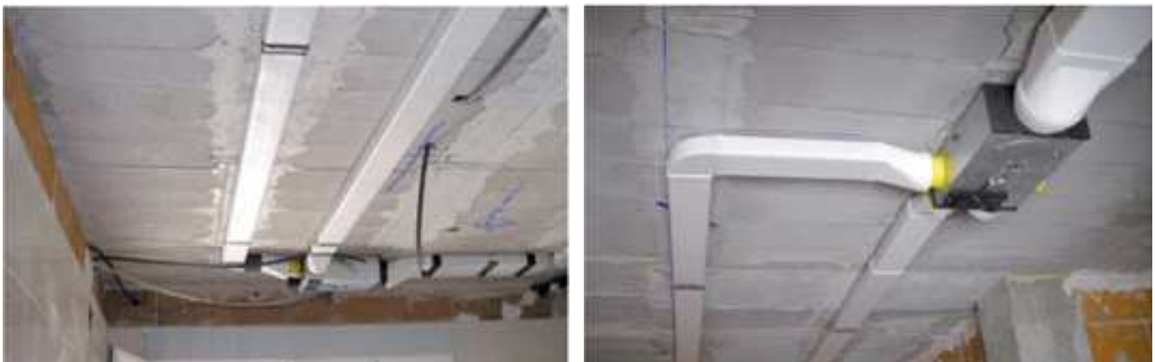
Col·locació de la xarxa de ventilació subjectada al forjat superior. Font: www.siberzone.es
