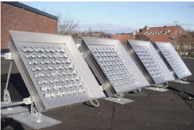
Panells captació de la llum a coberta. Font: Catàleg "Espacio Solar".
