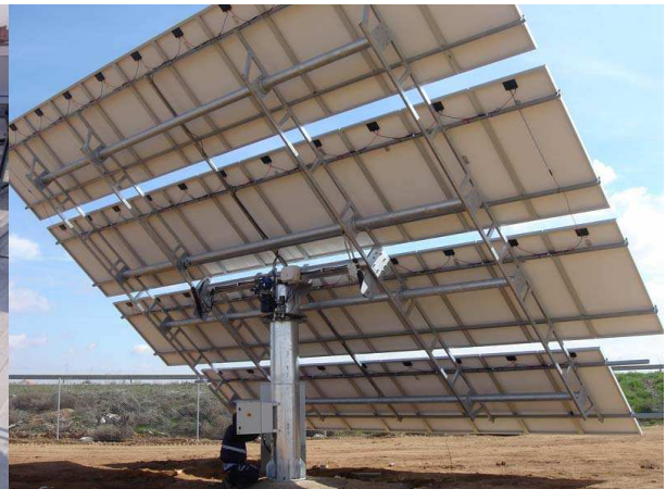
Plaques fotovoltaïques muntades sobre un suport amb seguiment solar de dos eixos. Font: Google imatges.
