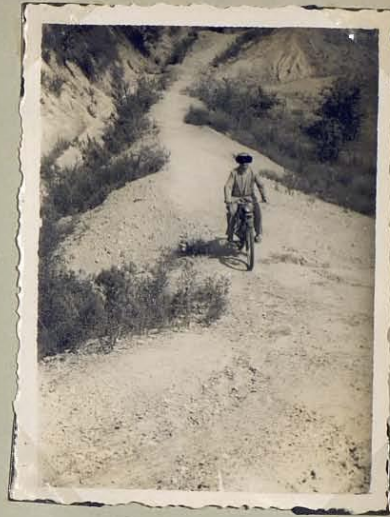
Un atajo peligroso de Estanyol, con doble talud
