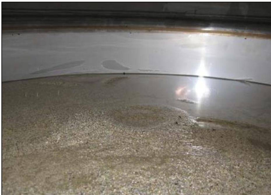
Figura 1.2. Vista interior del filtre amb medi filtrant granular (Burt, 2010).
