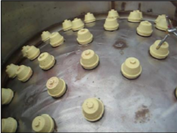
Figura 1.3. Cúpula de filtratge, vista interior (Burt, 2010).
