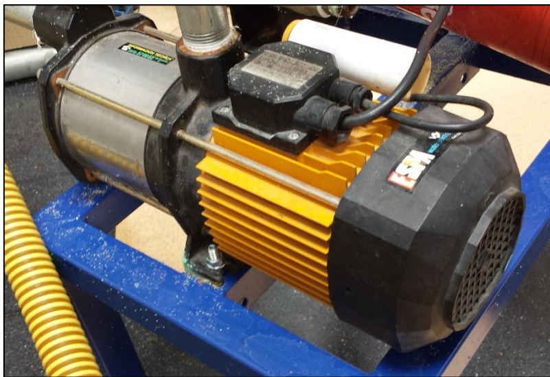
Figura 3.10. Bomba d'impulsió del circuit.
