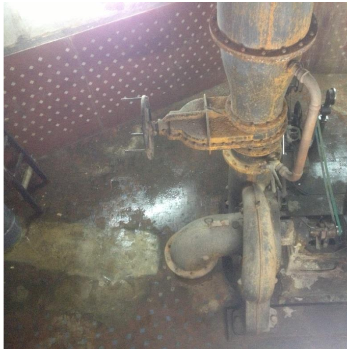
Figura 1 . Turbina instal·lada a la central
