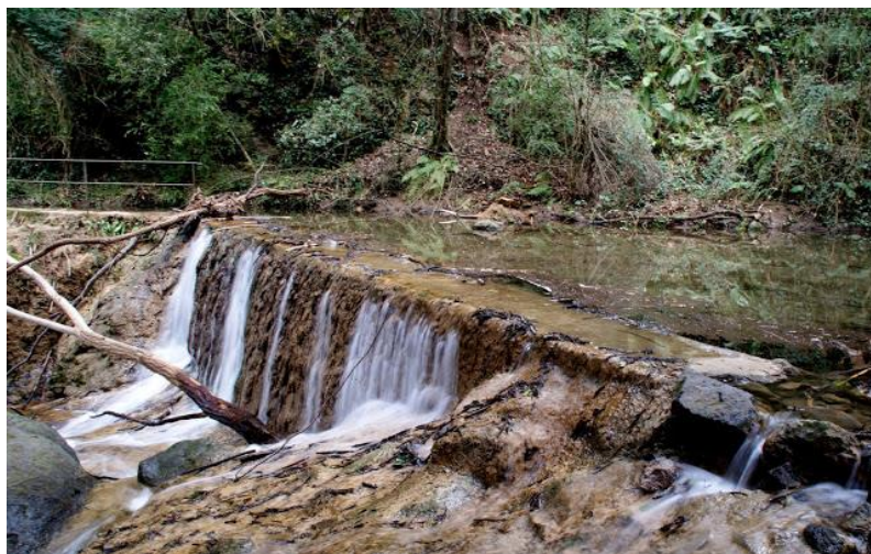
Figura 4. Reclosa que serveix per desviar l'aigua del riu
