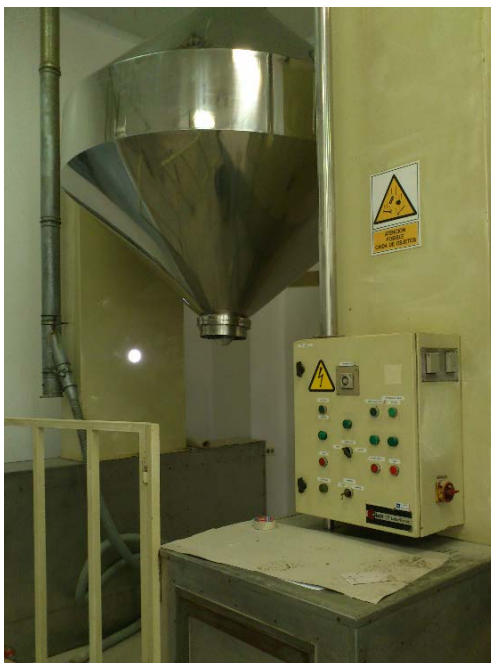
Figura 3. Estat actual de la barrejadora. [1]
