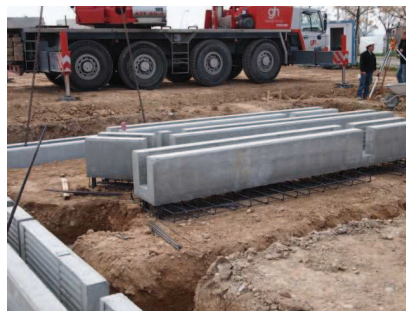
Imatge 5, 6 i 7. Sabata correguda formigó armat prefabricada.
