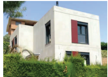
Imatge 13. Panells de formigó armat prefabricats amb fusteria ja incorporada Imatge cedida per Prêt a Porter, PMP.©
