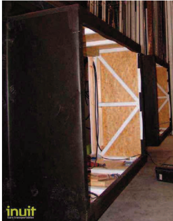
Imatges 30 i 31. Inuit- Impermeabilització de tot l'evolvent sobre taulers tipus OSB. Imatge de http://www.skaire.cat/inuit
