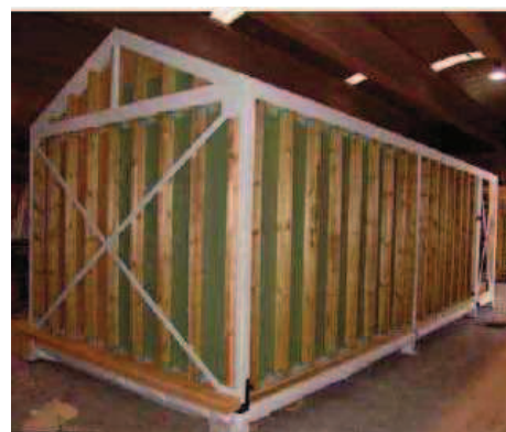
Imatges 28 i 29 . Inuit- Enllatat de l'evolvent. Disposició d'aïllament tèrmic entre llatres. Imatge de http://www.skairc.cat/inuit
