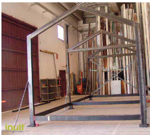
Imatge 23 . Inici muntatge estructura Imatge de http://www.skaire.cat/inuit
