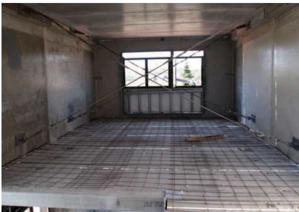
Imatge 11. Forjat amb plaques alleugerides i mallazo col·locat, esperes dels panells doblegades i estructura atirantada a disposició de la capa de compressió. Imatge cedida per Prêt a Porter, PMP.©
