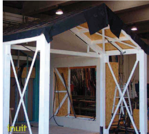
Imatges 30 i 31. Inuit- Impermeabilització de tot l'evolvent sobre taulers tipus OSB. Imatge de http://www.skaire.cat/inuit
