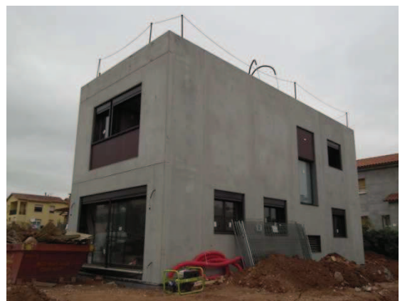
Imatge 12. Estructura i tancaments conformats. Monolitisme consolidat. Imatge cedida per Prêt a Porter, PMP.©
