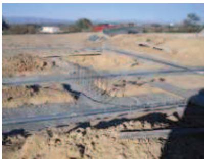
Imatge 5, 6 i 7. Sabata correguda formigó armat prefabricada.
