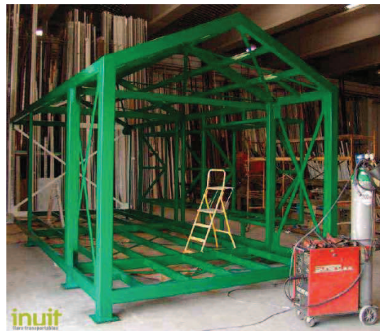
Imatge 24 . Estructura. Protecció amb pintura intumescent. Imatge de http://www.skaire.cat/inuit
