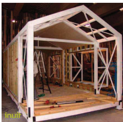
Imatges 28 i 29 . Inuit- Enllatat de l'evolvent. Disposició d'aïllament tèrmic entre llatres. Imatge de http://www.skairc.cat/inuit
