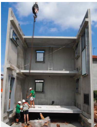
Imatge 10. Muntatge elements estructura Imatge cedida per Prêt a Porter, PMP.
