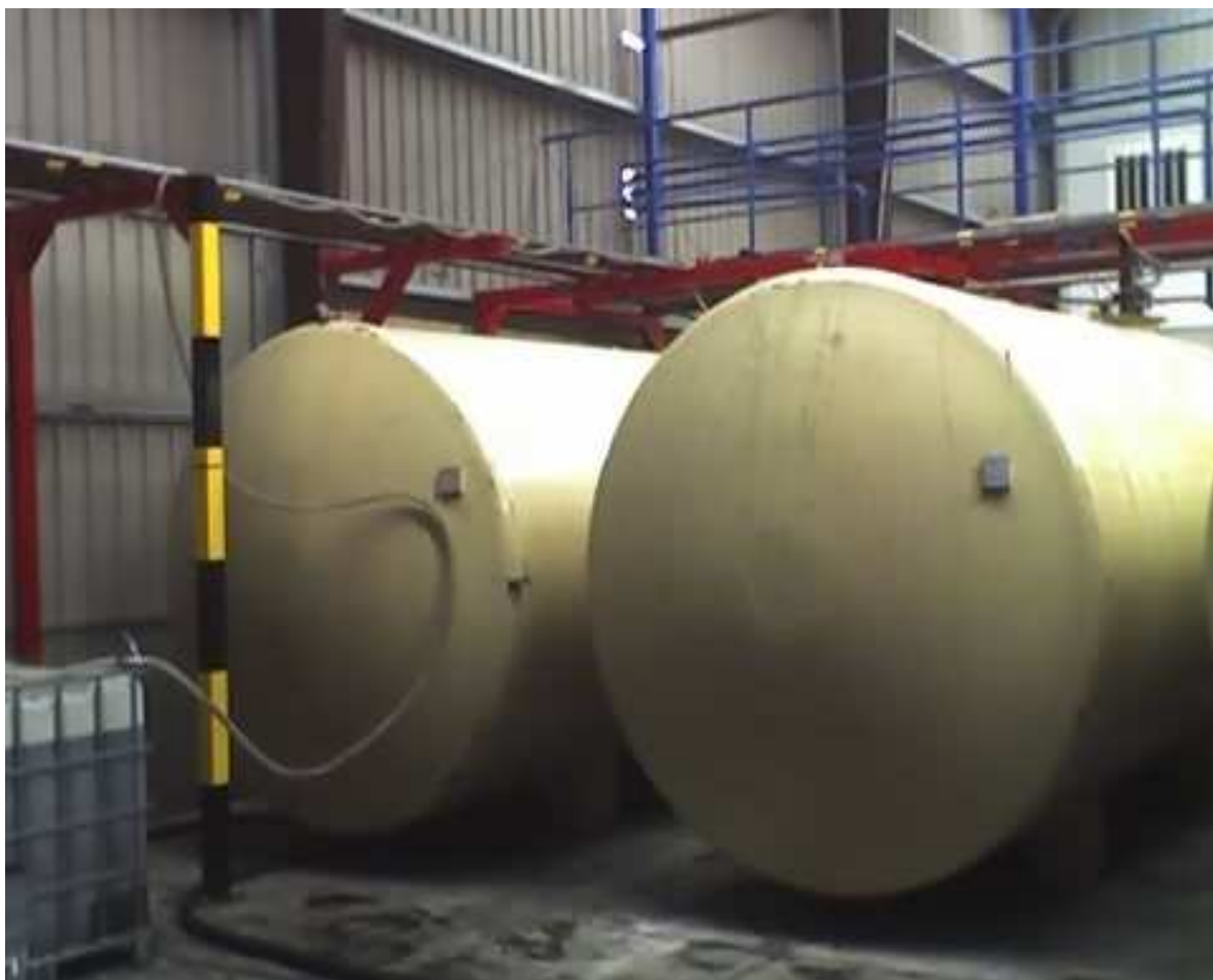
Figura A5. Dipòsits d'emmagatzematge.
