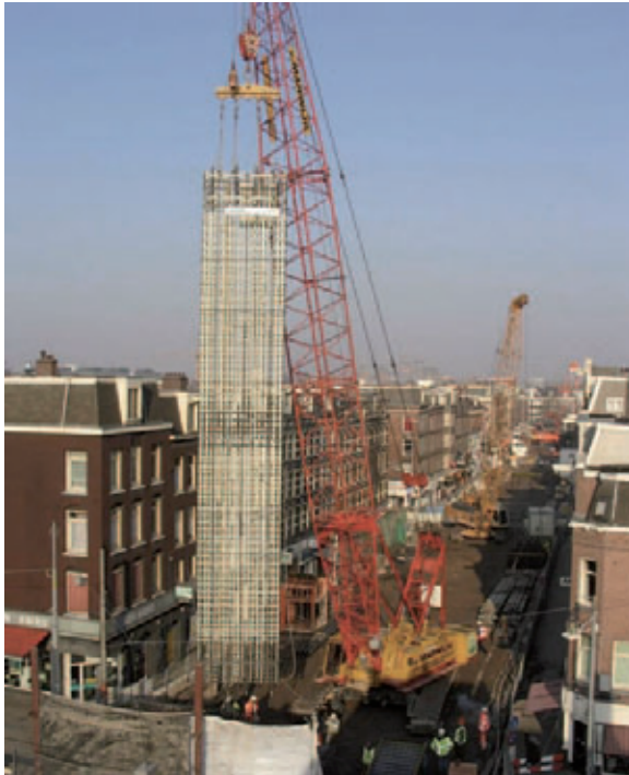
Figura 7. Reforç de la paret diafragma que serà foradada per la màquina tuneladora (Línia de metro, Amsterdam).
