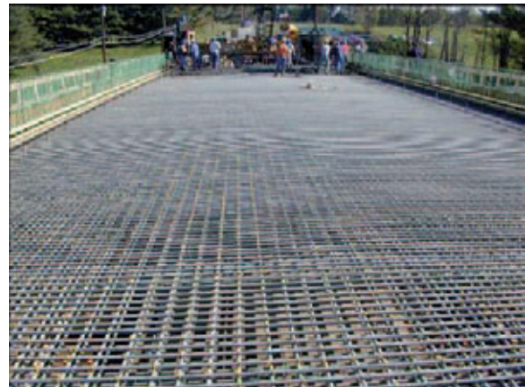
Figura 6a. Armadura de tauler de pont (EUA).
