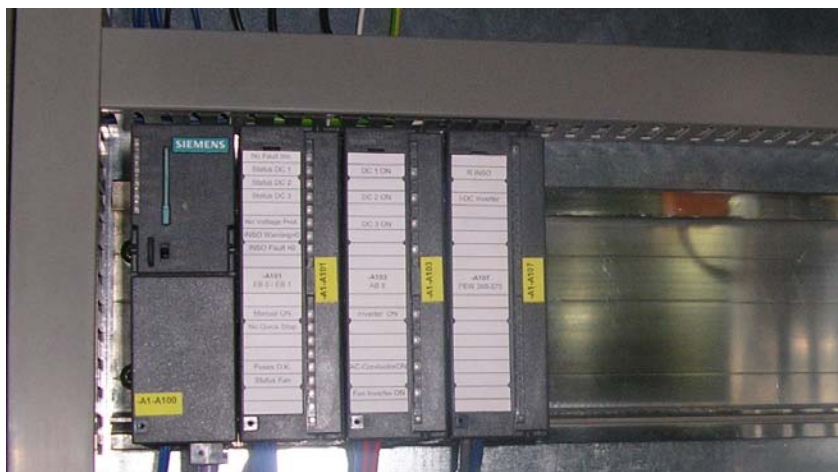
Figura 19. Imatge de la CPU del Sinvert
