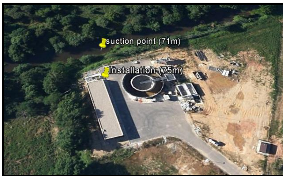
Figura 5: Punts de succió al riu i instal·lació a la Depuradora
