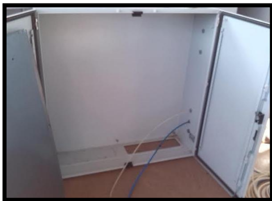
Figura 20: Caixa per a la instal·lació dels sensors
