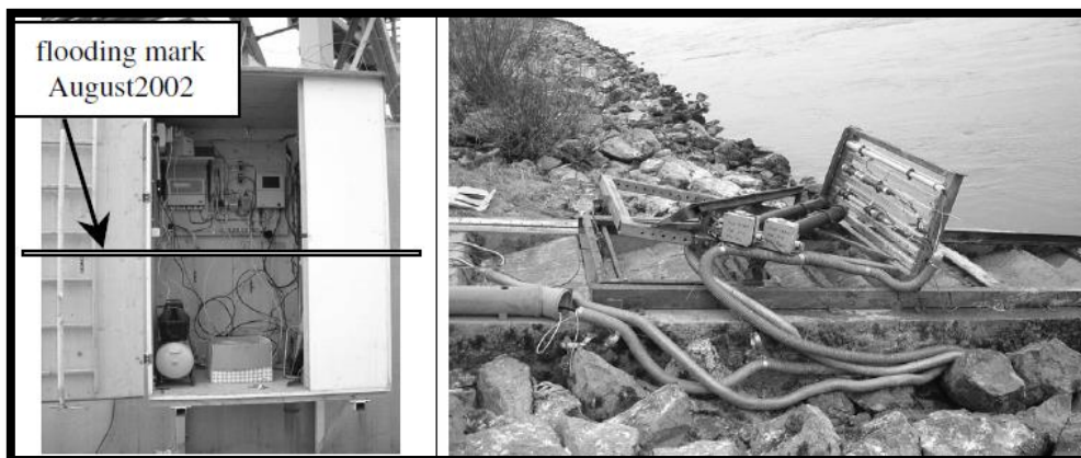
Figura 3: Instal·lació de monitoreig en rius a Viena
