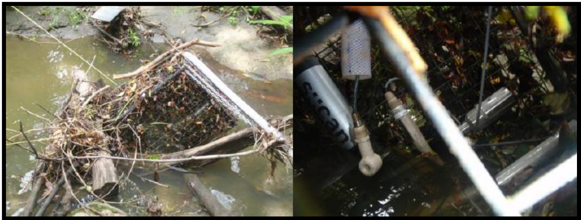
Figura 1: Instal·lació de Queretaro, Mèxic
