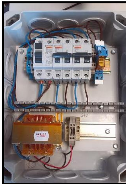
Figura 34: Muntatge elèctric acabat
