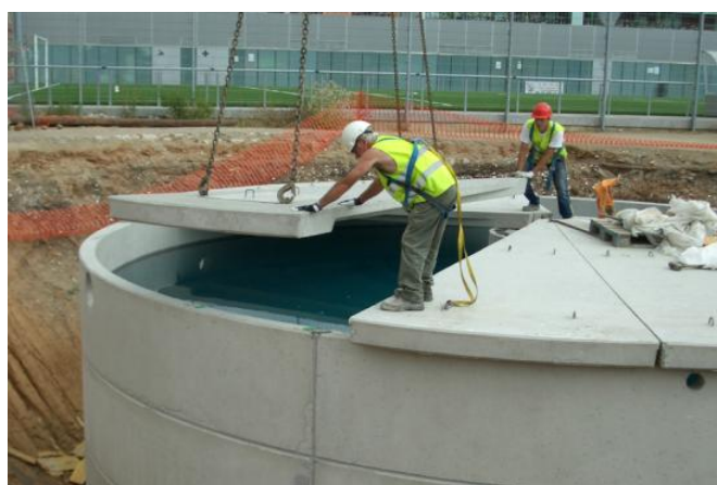
Figura A.31 Fase final de la construcció del dipòsit.
