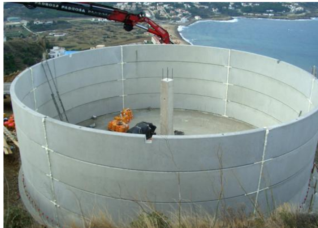
Figura A.30 Tercer fase de construcció del dipòsit.
