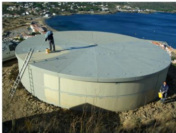
Figura A.27 Imatge de dipòsit circular de formigó prefabricat amb coberta.
