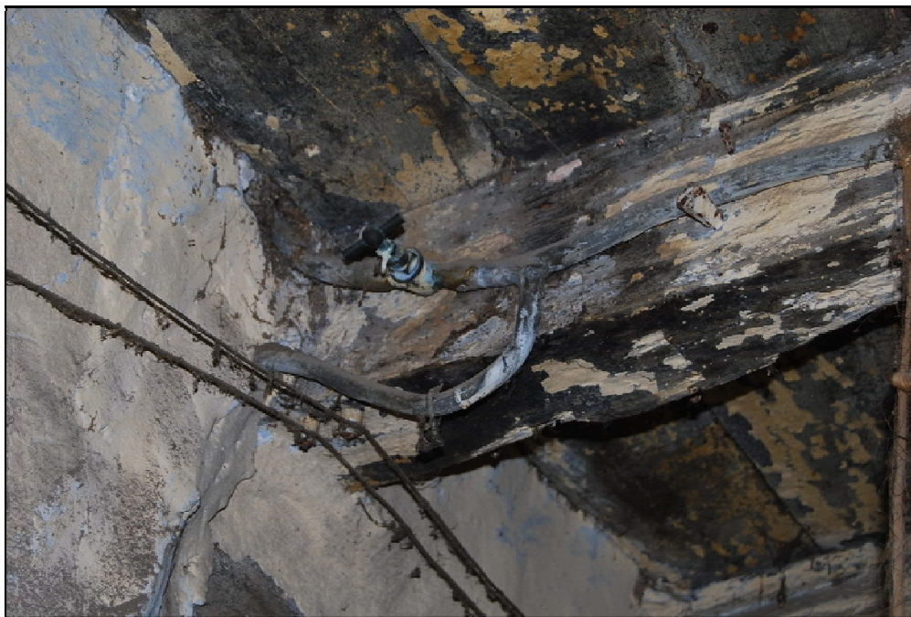
Fot.B- 27 Instal·lació de fontaneria, tub de plom/ FONT: (els Autors, 2013)
