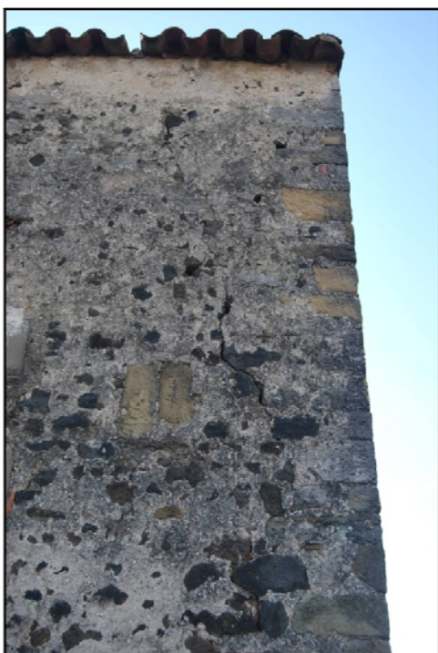
Fot.B- 43 Esquerda a façana Nord / FONT: (els Autors, 2013)
