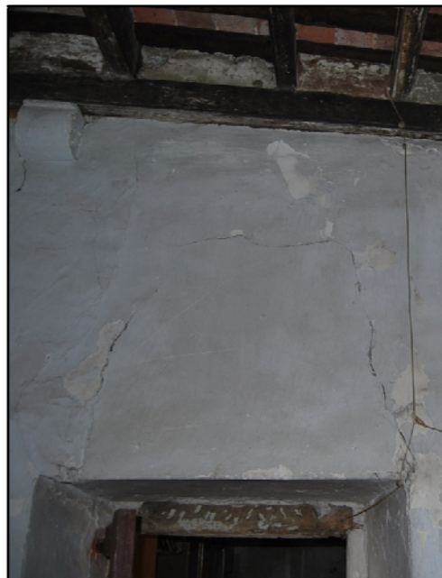
Fot.B- 46 Esquerda en dintell de porta interior, Mas Jonquer / FONT: (els Autors, 2013)
