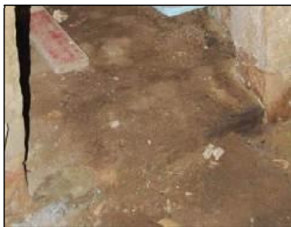
Fot.B- 19 Paviment de terra, sense paviment/ FONT: (els Autors, 2013)
