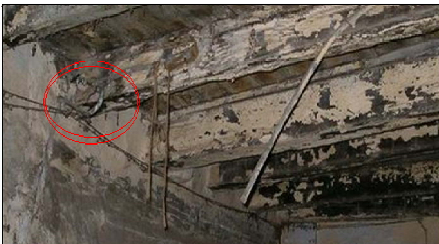
Fot.B- 26 Instal·lació de fontaneria, tub de plom / FONT: (els Autors, 2013)
