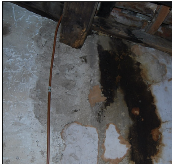
Fot.B- 48 Encastament de biga de fusta a paret amb acabat de calç / FONT: (els Autors, 2013)
