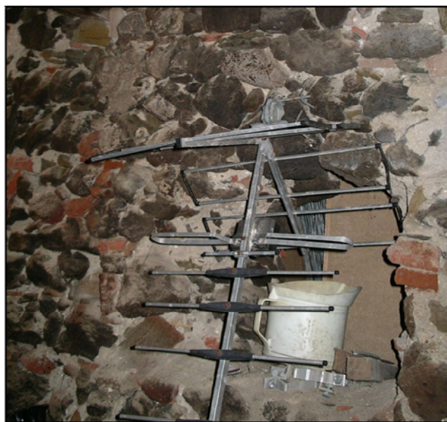
Fot.B- 13 Paret interior sense revestiment / FONT: (els Autors, 2013)
