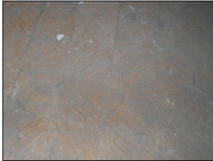
Fot.B- 16 Paviment amb ceràmica vitrificada / FONT: (els Autors, 2013)
