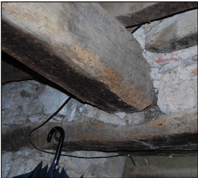
Fot.B- 47 Encastament de cairat a paret sobre llinda / FONT: (els Autors, 2013)
