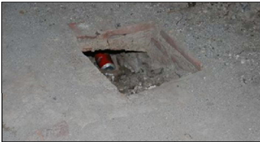
Fot.B- 25 Clavegueró enterrat / FONT: (els Autors, 2013)
