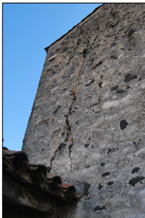
Fot.B- 44 Esquerda a façana Est / FONT: (els Autors, 2013)
