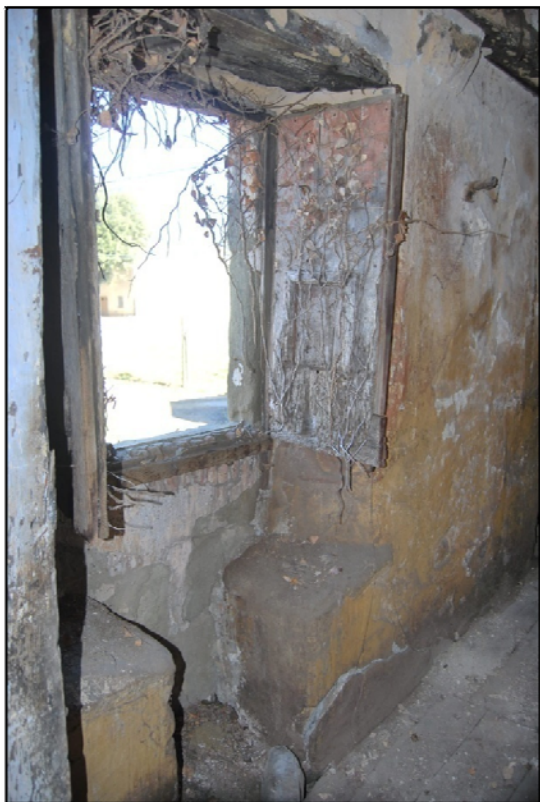
Fot.B- 36 Arrels que entren fins a l'interior / FONT: (els Autors, 2013)
