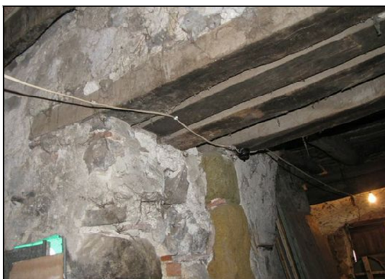
Fot.B- 28 Instal·lació vista de baixa tensió / FONT: (els Autors, 2013)
