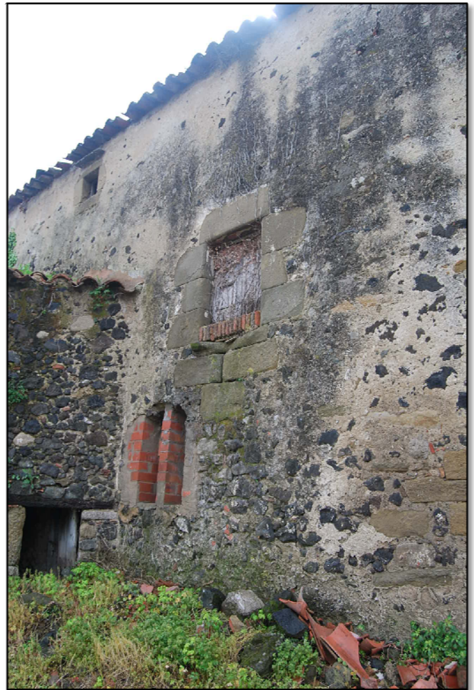
Fot.B- 32 Humitats i vegetació mur cara exterior/ FONT: (els Autors, 2013)
