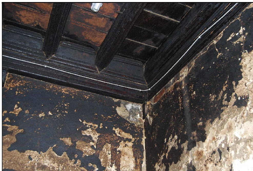
Fot.B- 38 Cuina amb evidència de sutge de la llar de foc a parets i sostre / FONT: (els Autors, 2013)
