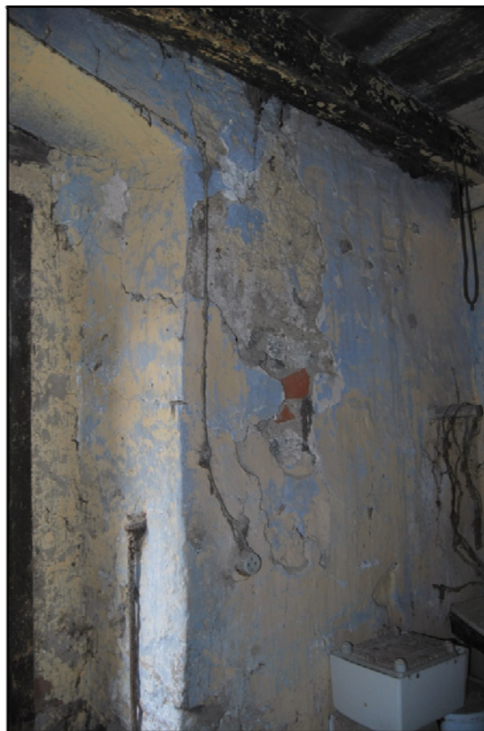
Fot.B- 37 Paret interior amb manca de manteniment / FONT: (els Autors, 2013)
