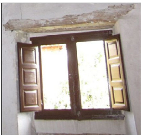
Fot.B- 20 Finestra amb dues fulles batents / FONT: (els Autors, 2013)
