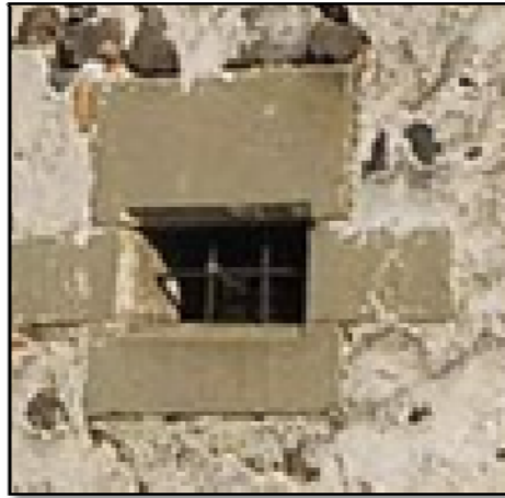
Fot.B- 22 Ventilació amb barrots de planta baixa / FONT: (els Autors, 2013)
