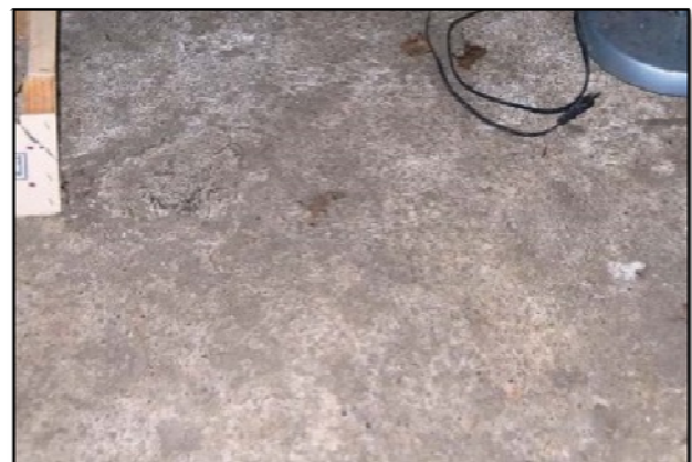
Fot.B- 18 Paviment amb una capa de formigó / FONT: (els Autors, 2013)
