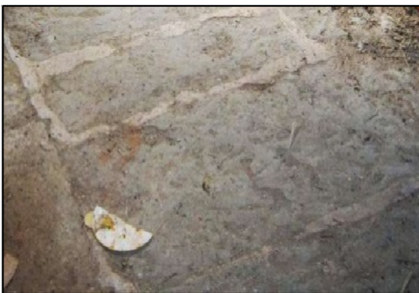
Fot.B- 17 Paviment amb lloses de pedra / FONT: (els Autors, 2013)
