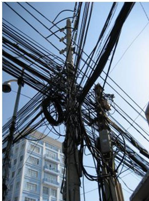
Figura 5. Si la iluminación uniforme del fondo decrece, la visibilidad de los hilos decae de una manera rápida. Aquí no se trata de separar dos puntos próximos, sino que lo que en realidad, analiza el ojo es la existencia de una sombra sobre un fondo con una luminosidad uniforme. Es decir, se trata de una sensibilidad al contraste y no de un minimum separable.
