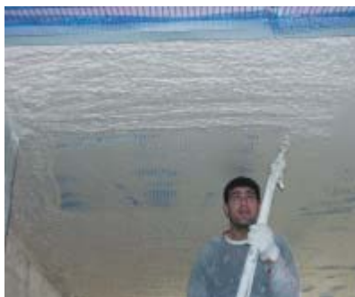
Imatge 6.6. Projecció d'arrebossat de guix sobre els panells capil·lars.
