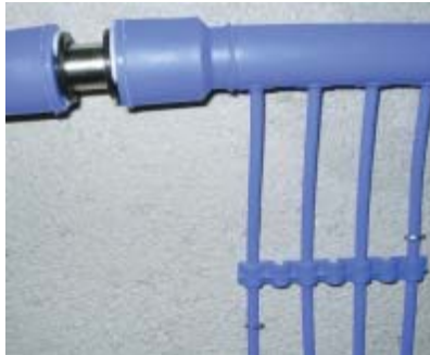
Imatge 6.4. Fixació mitjançant grapes dels panells capil·lars al sostre.
