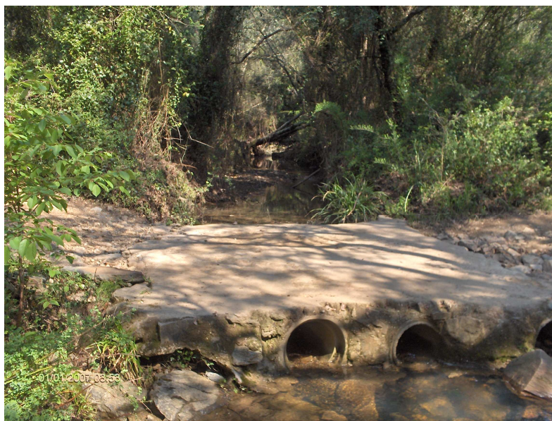
Punt de mostreig 1, Torrent Bo aigües amunt. Punt crític: tubs de gual parcialment embussats. Font: Horitzó Verd S.C.
