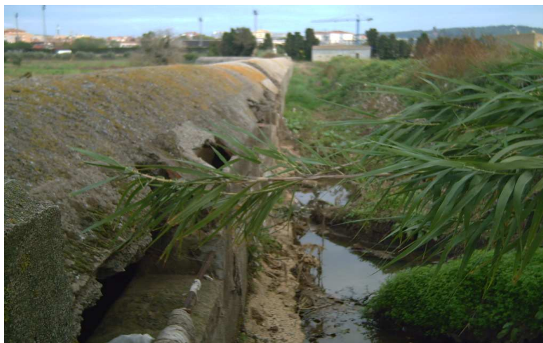
Punt de mostreig 2. Sobreeixidor aigües amunt, mirant cap a Palafrugell. S'observa col·lector en mal estat. Font: Horitzó Verd S.C.
