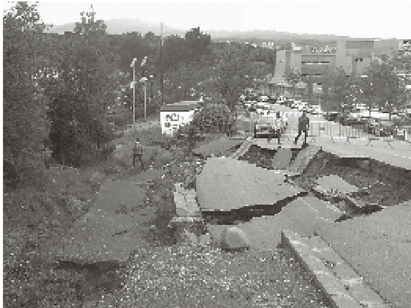
Foto 3. Esllavissament derivat d'un fort episodi plujós que va afectar les infraestructures d'una àrea urbana. Carrer annex a l'estadi de Montilivi, a Girona.
