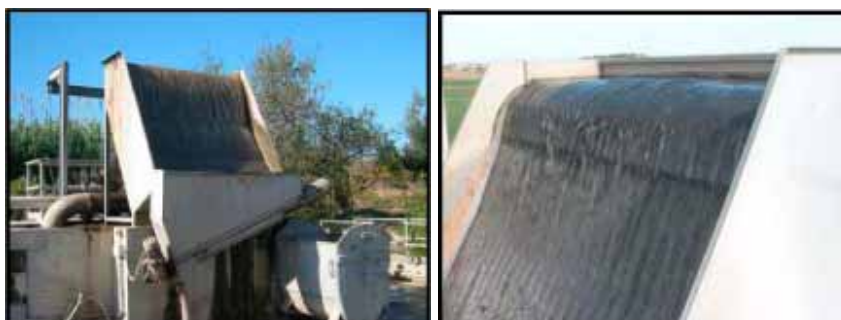
Figura 3.5. Imatges de reixes de fins de tipus tamisos parabòlics
