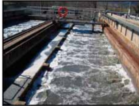
Figura 3.6. Instal·lació d'un dessorrador-desgreixador
