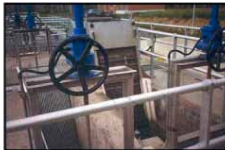
Figura 3.3. Imatge de reixes de grollers
