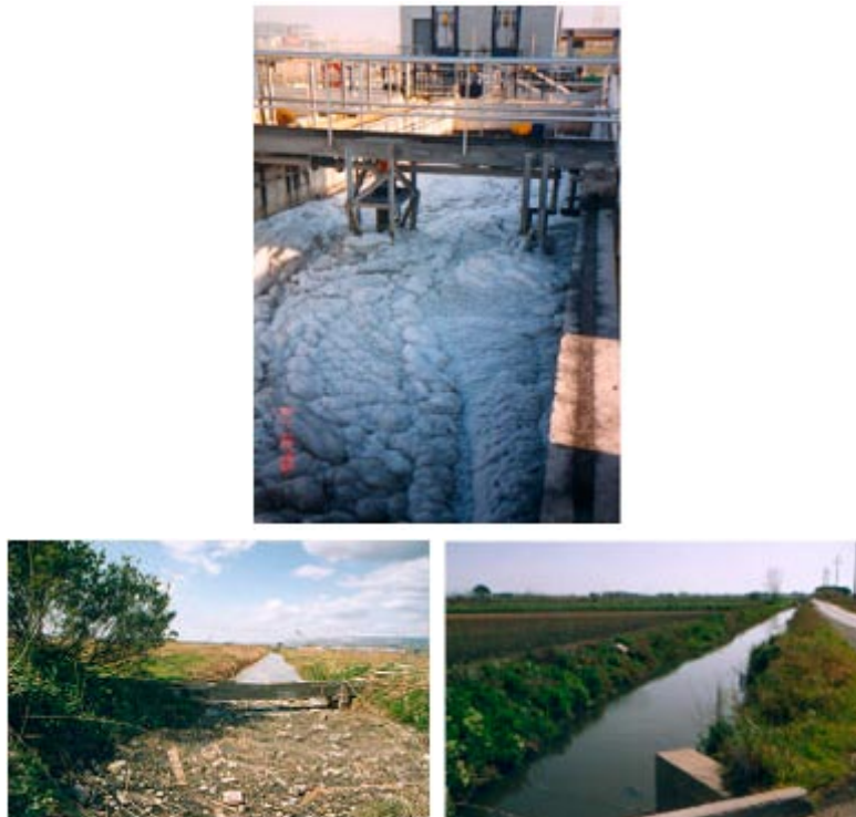
Figura 4.27. Corredor contaminat i recuperat amb aigua residual depurada.
