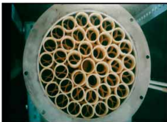
Figura 3.50. Rebliment ordenat d'un filtre anaerobi
