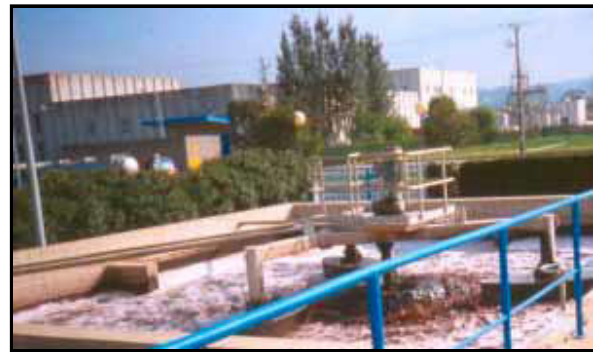
Figura 3.25. Turbina superficial
