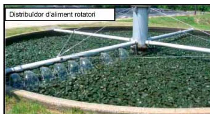
Figura 3.36. Imatge d'un filtre percolador soterrat
