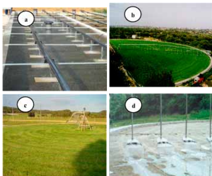
Figura 3.64. Exemples d'infiltració-percolació: a) Aurignac (França), b) Sant Lluís, c) Vall-llobrega i d) els Hostalets de Pierola
