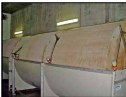
Figura 3.40. Biodisc amb etapes en sèrie
