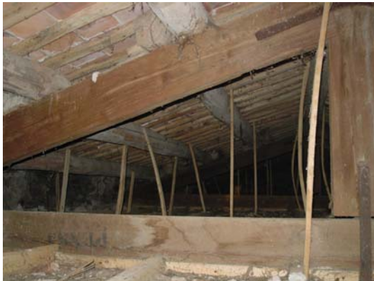
Estructura actual de la coberta amb encavallades i bigues de fusta
