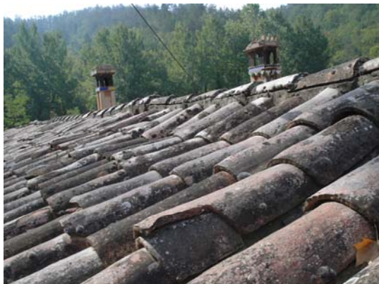
Vista general de la coberta
