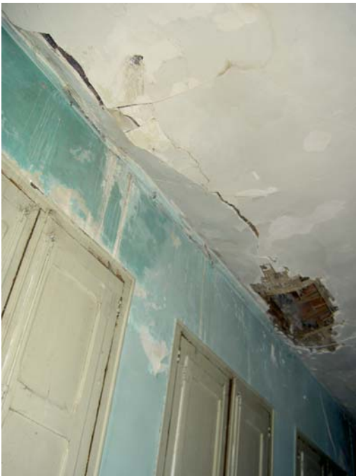
Fals sostre a la zona de l'aula de l'escola
