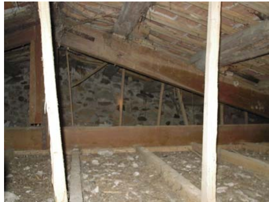
Estructura actual de la coberta amb encavallades i bigues de fusta
