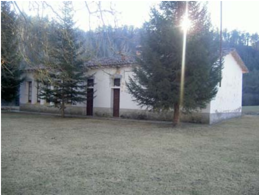
Façana principal actual
