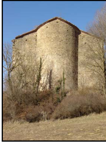
b) Façana posterior de l'església de St. Julià.
