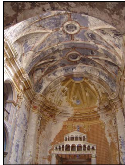
b) Vista interior de la part barroca de l'església de St. Julià.
