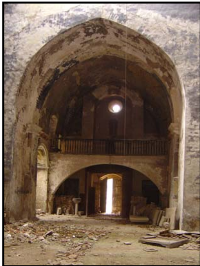
a) Vista interior de la part romànica de l'església de St. Julià.
