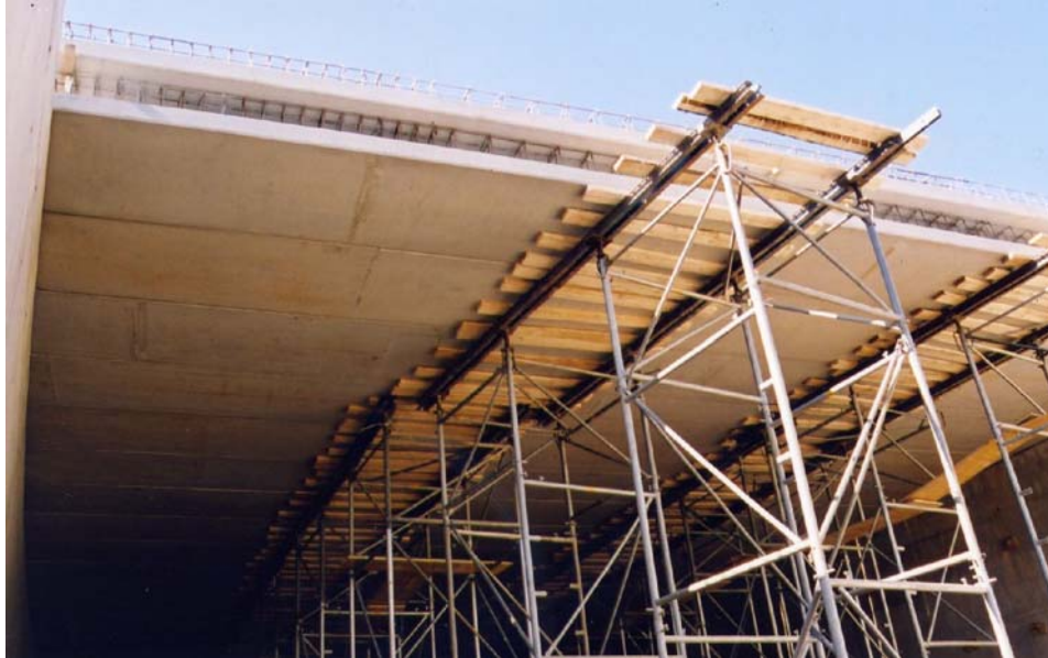
Figura 22: Vista del apuntalamiento de las prelosas con las torres.
