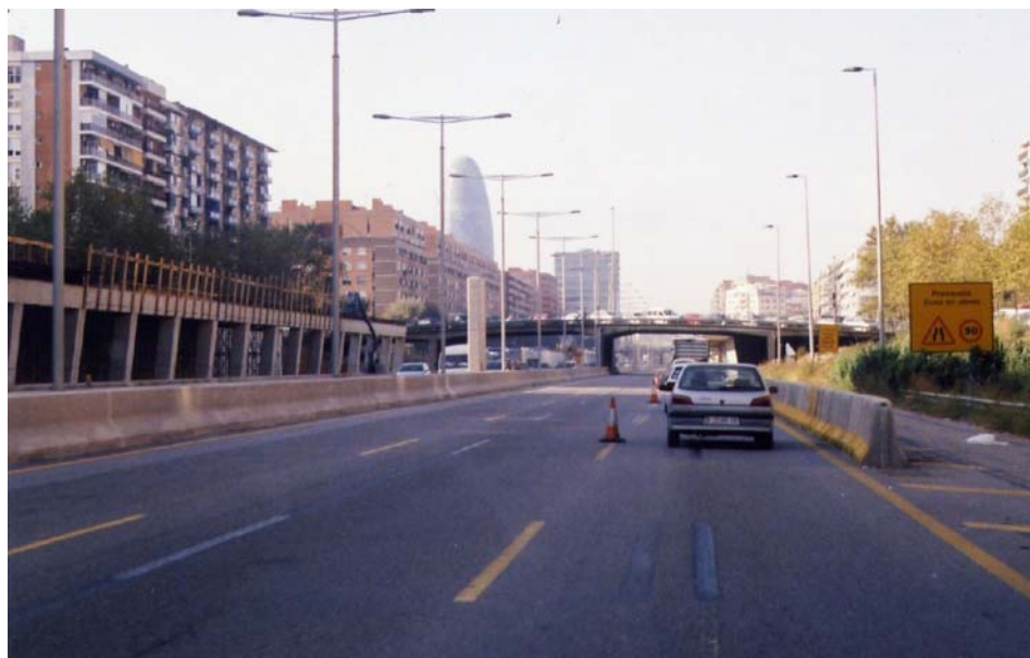
Figura 20: Vista de la construcción en la Gran Vía con la torre Agbar al fondo.
