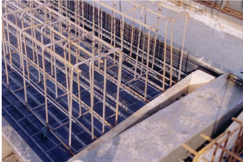
Figura 24: Detalle de la pista de prefabricación de la empresa Atefor.
