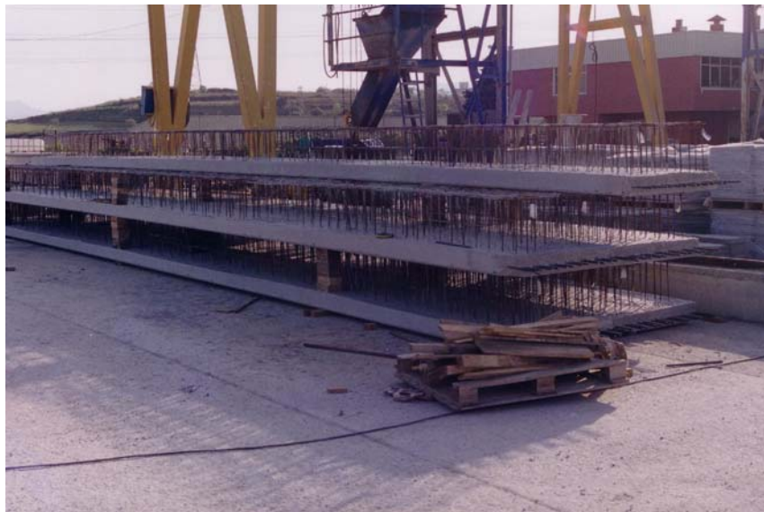
Figura 25: Vista de las prelosas acabadas.
