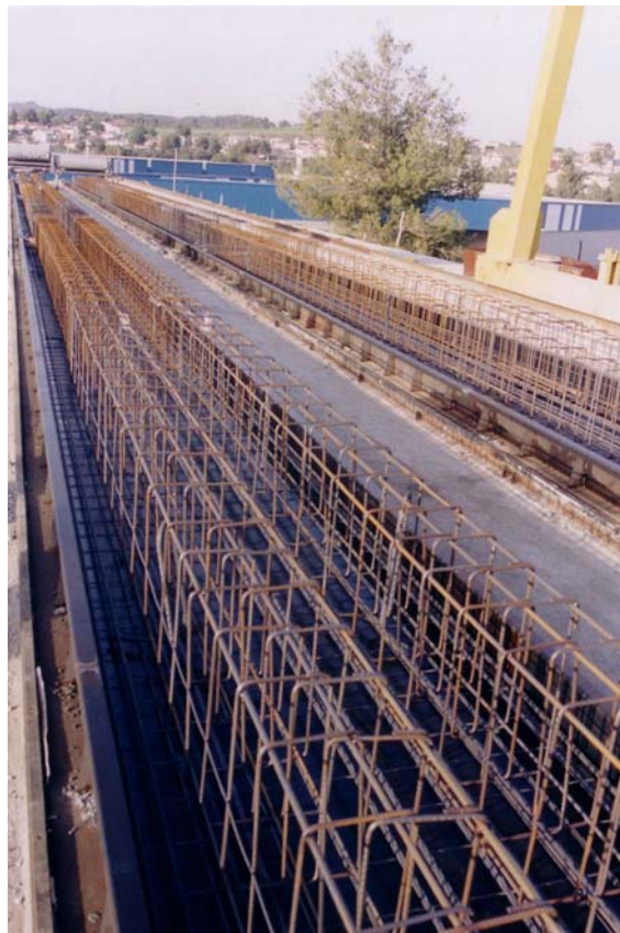
Figura 23: Vista de la pista de prefabricación de la empresa Atefor.
