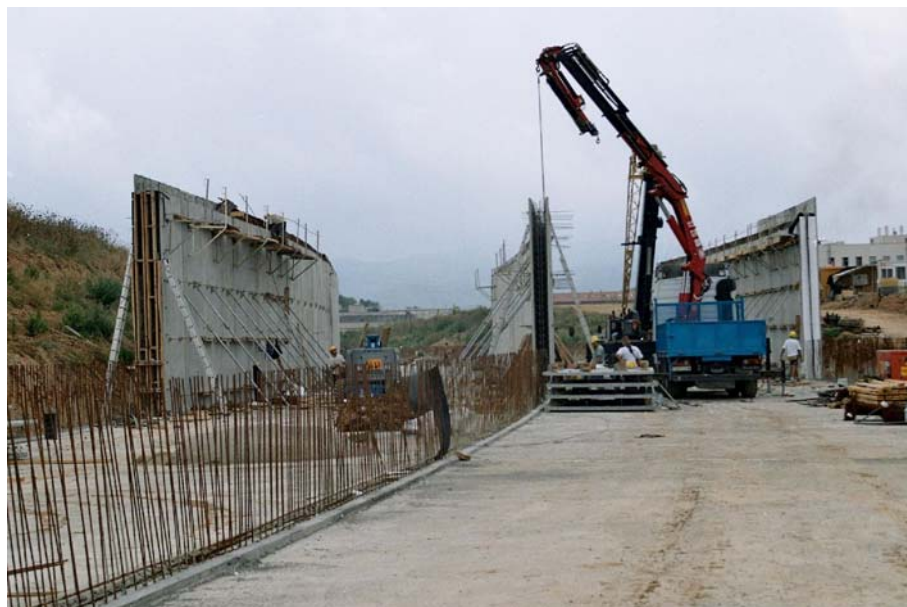
Figura 26: Vista de la colocación de prelosas para construir los muros de la estructura semi-prefabricada en la Ronda Norte de Sant Cugat.
