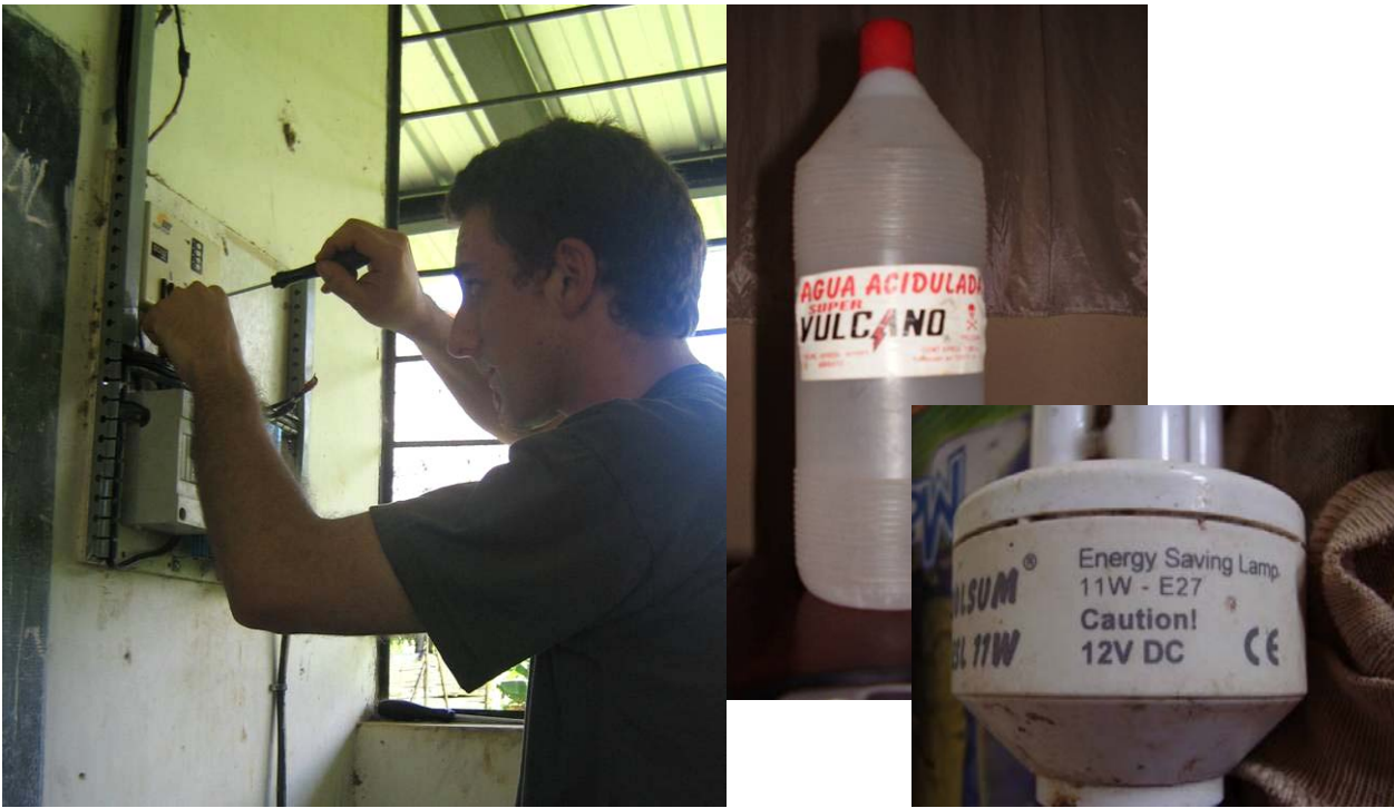
Figura 30 i 31.- Inspecció, aigua acidulada i bombeta 11W 12VDC Kaspizapa (font: ESF-2006)
