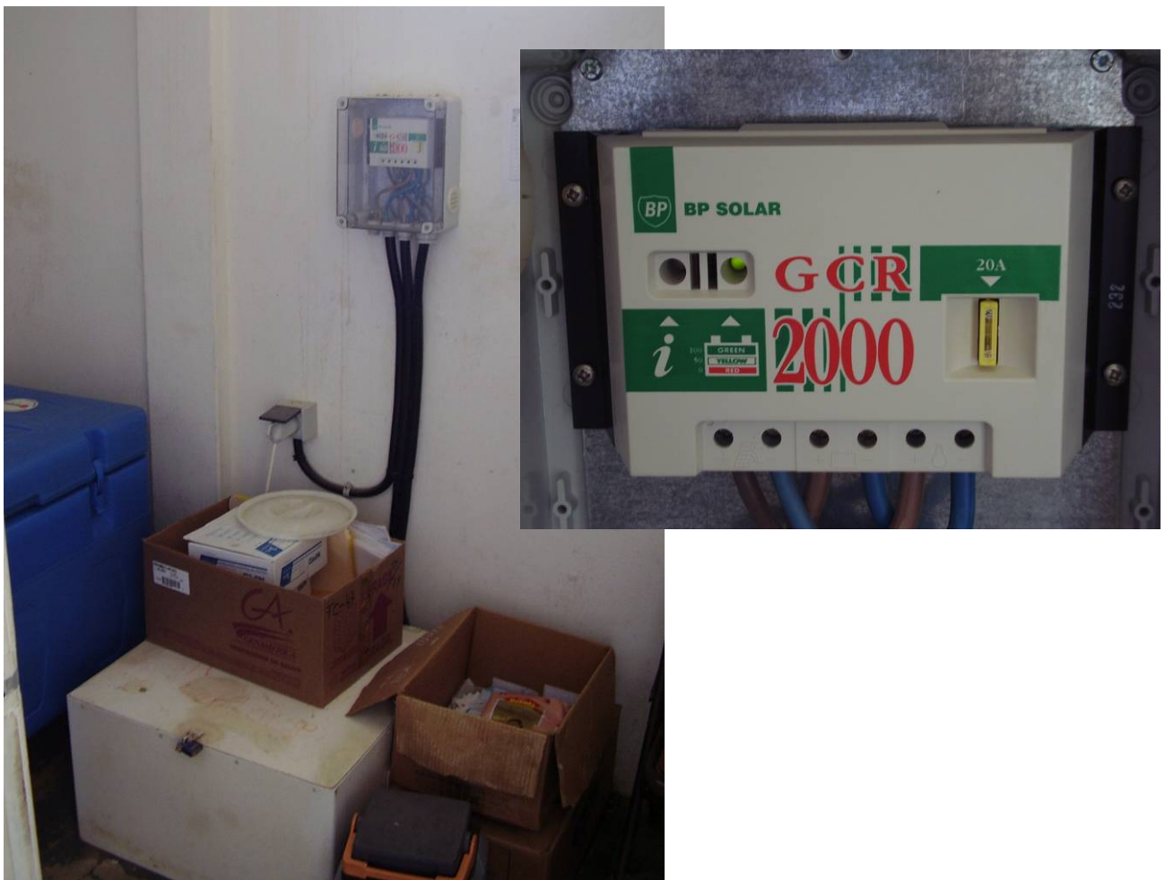
Figura 32 i 33.- Muntatge i regulador de la Misión Pompeya (font: ESF-2006)
