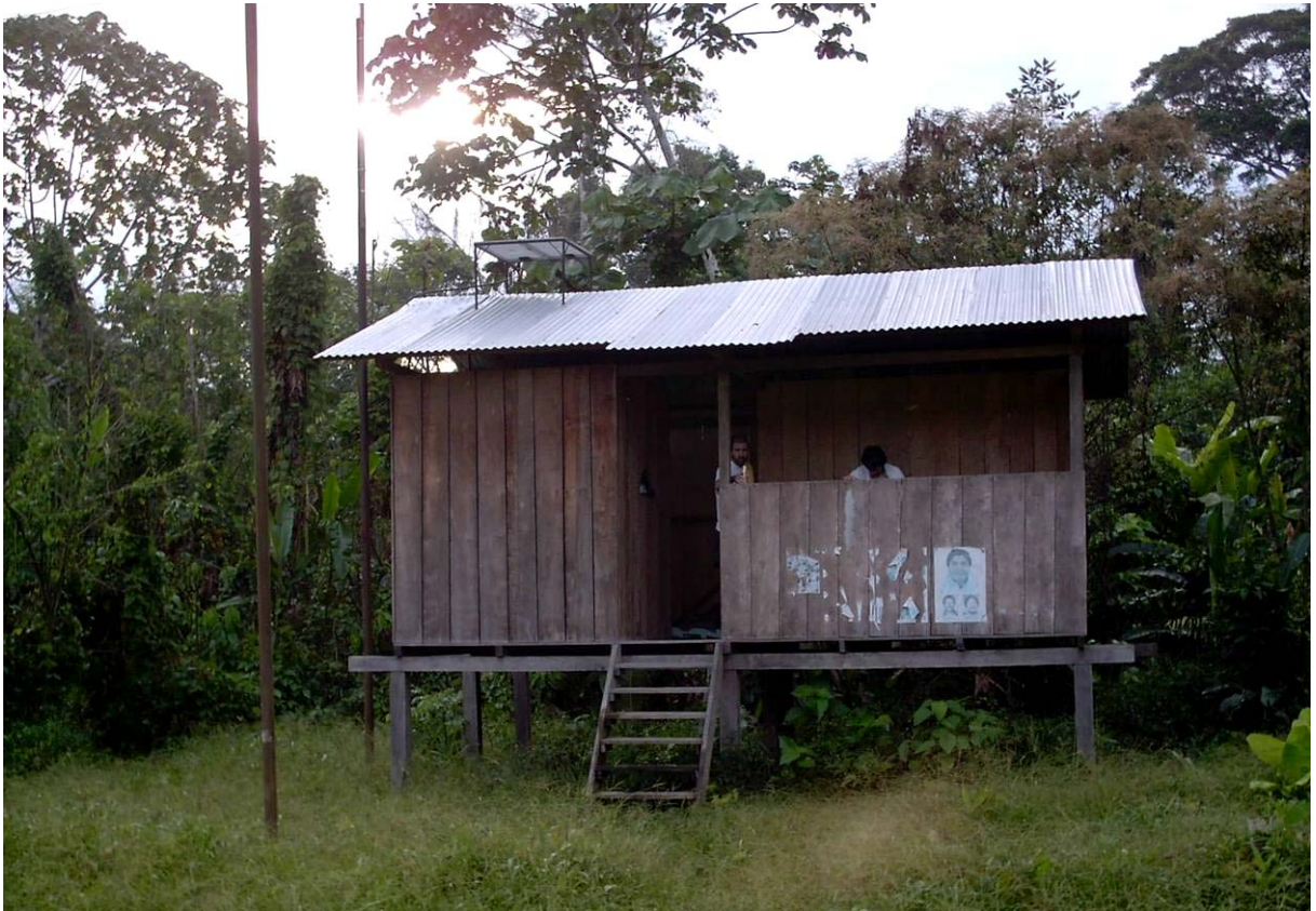
Figura 14.- Instal·lació Solar per a la radio de la comunitat siona de Puerto Bolívar (font: ESF-2003)
