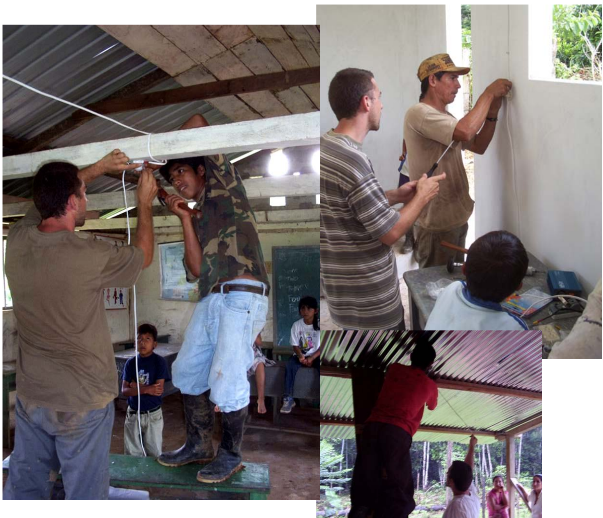
Figura 49, 50 i 51.- muntatge de la instal·lació interior: Unión Laureense, Flor de la Palma i Unión 2000 (font: ESF-2006)
