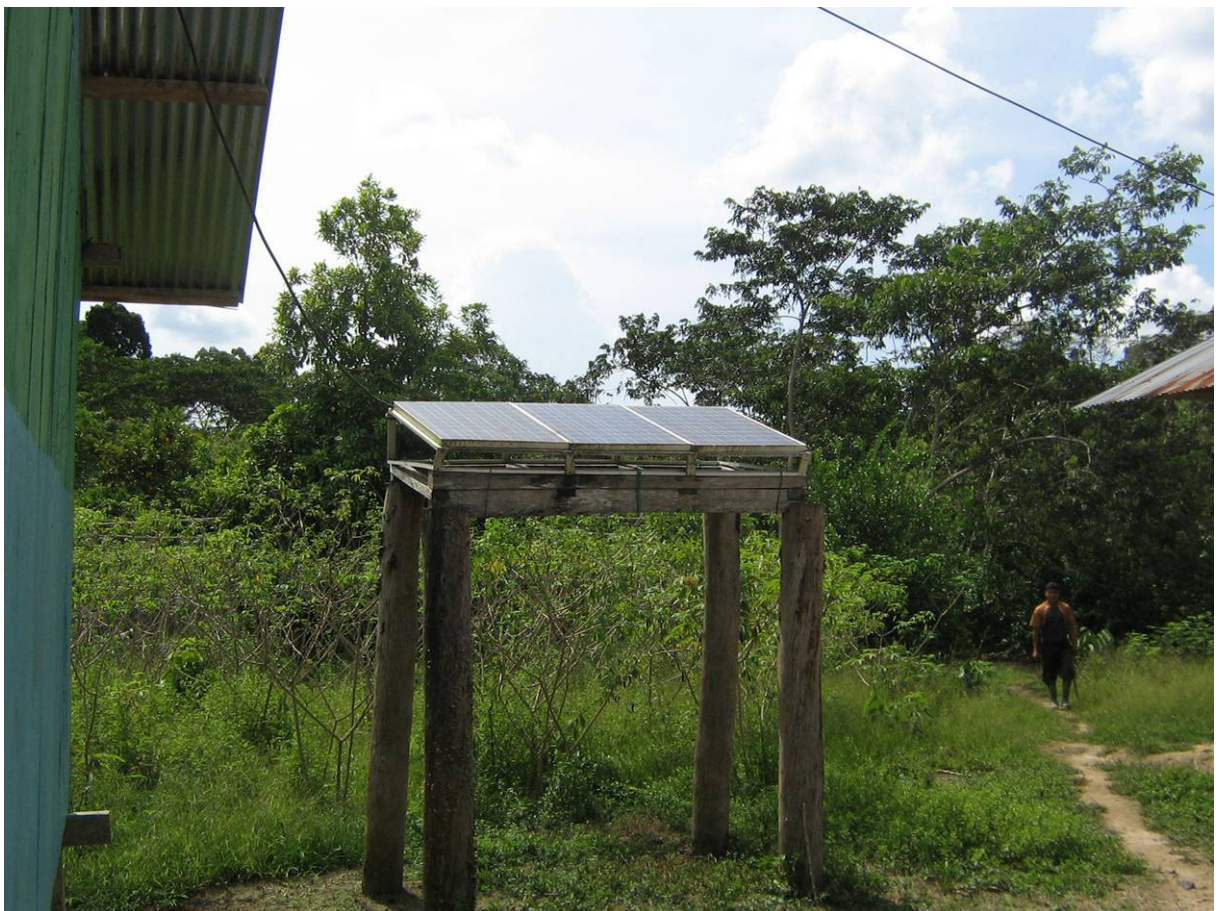
Figura 35.- Estructura i panells del sistema de la comunitat shuar de Nantip (font: ESF-2006)
