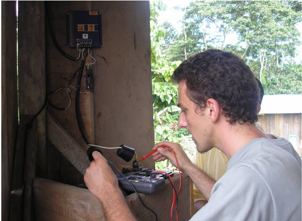
Figura 37.- Inspecció muntatge de la comunitat quichua de Cuchapamba (font: ESF-2006)
