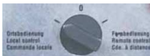
Figura 37: Selector manual-0-automàtic de la comporta.
