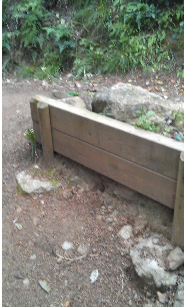
Foto 30. Mur de contenció contra l'erosió Font pròpia.
