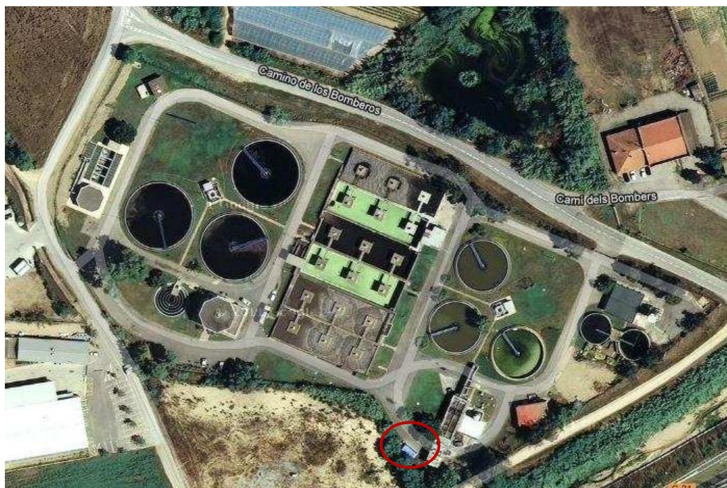
Figura 1. Vista aèria de l'EDAR i situació de la planta pilot
