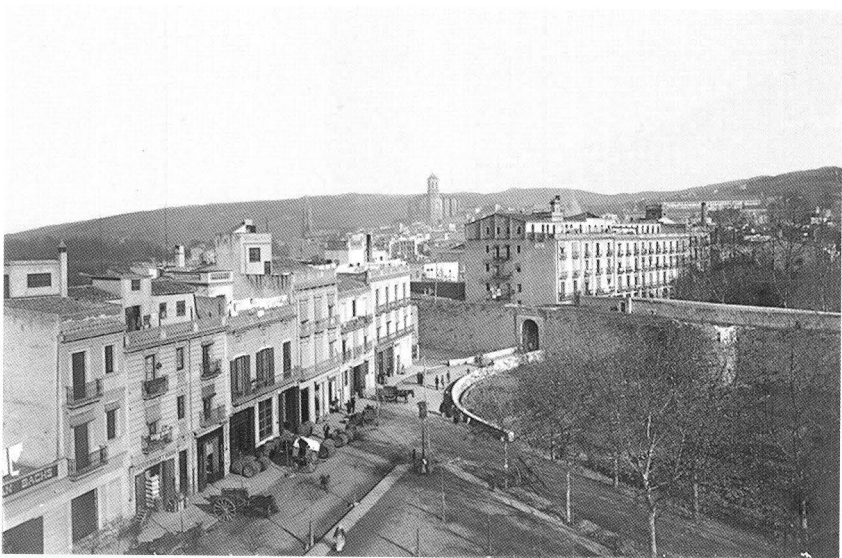
Figura 7. VISTA DE LES MURALLES DE GIRONA DES DE LA CARRETERA DE SANTA EUGÈNIA (Fons Diputació de Girona).
