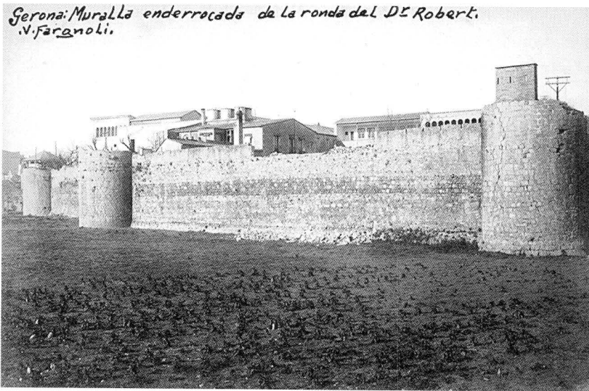
Figura 2. VISTA DE LES MURALLES DES DE LA ZONA DEL PLA DE GIRONA (Fons Diputació de Girona).
