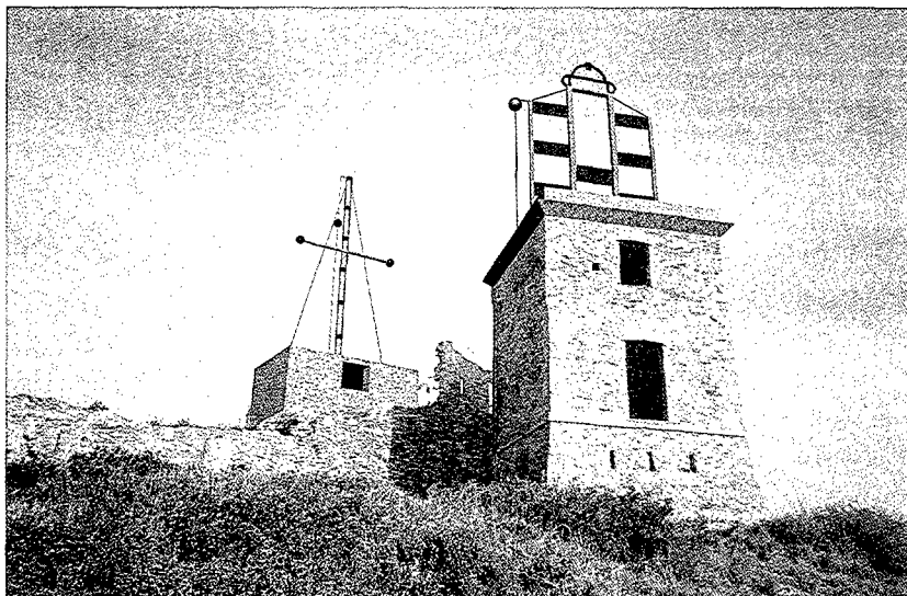
FOTOGRAFIA 4: Vista general del conjunt abans de la seva restauració i proposta de restitució dels aparells de telegrafia òptica, de les línies militar i civil. En ella es pot observar com el sistema militar era més senzill que el civil, fet lògic si hom té present la urgència que presidí la seva posada en servei, mentre que l'aparell civil era més elaborat i realitzat amb materials més resistents. Concretament, tot l'aparell pesava uns 1017,2 kg.
