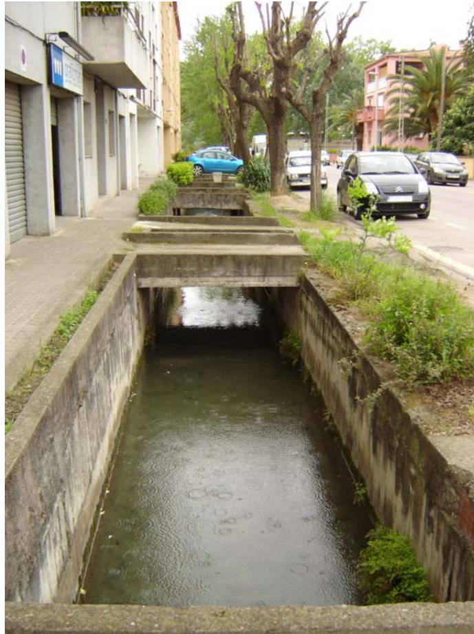
Figura 19. Canalització del Rec d'en Teixidor mitjançant murs de formigó. Foto: MENTOR S.L.
