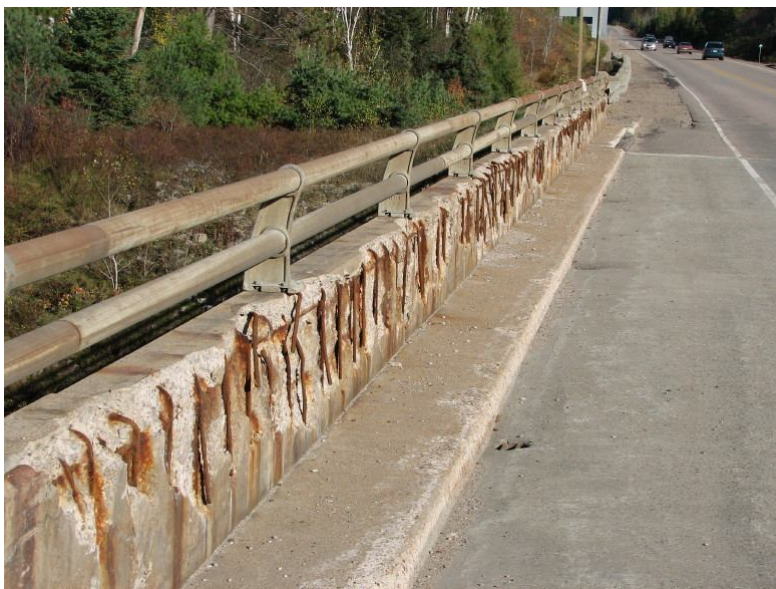
Figura 1: Deteriorament a causa de l'oxidació o corrosió de l'acer
