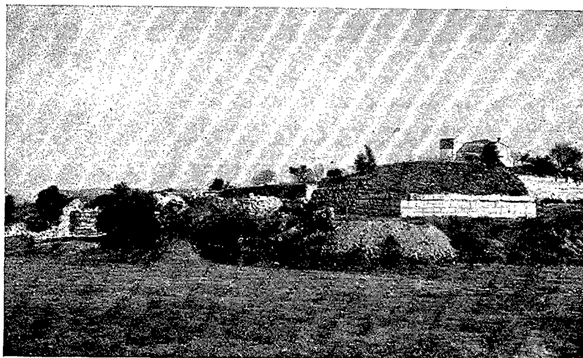
2. Aspecto total de la excavación de la muralla Frigoleta y de la muralla Sur.
