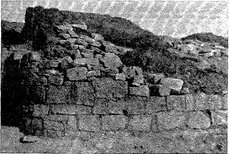
2. Torre circular de la muralla Frigoleta.
