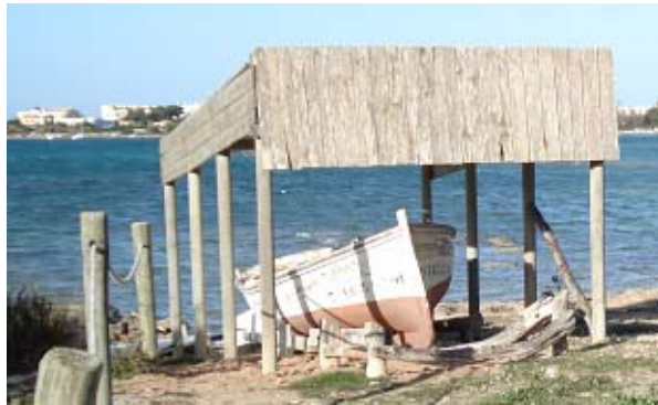
Foto 36. Varador cobert i restaurat
