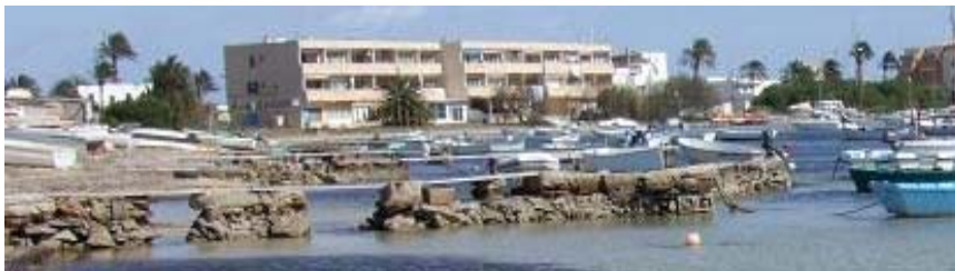
Foto 46. Exemple de moll en mal estat
