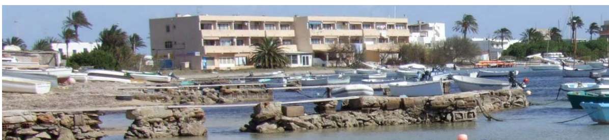
Foto 34: sector de la zona nord de l'Estany. S'aprecien diferents molls mal construïts en una zona fortament antropitzada.
