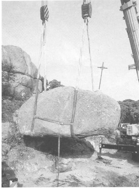
Foto 4: Segona fase de la reposició: la roca s'aixeca i es desplaça fins a deixar-la en la plataforma provisional preparada a la base de la torre rocallosa.
