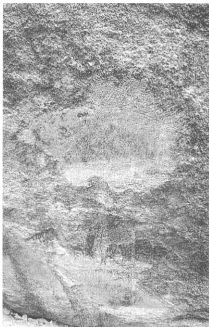
Foto 6. Tercera fase de la reposició: amb una serra radial es retoca la superfície sobre la qual s'ha de recolzar la pedra. Fotografia de Josep Vidal.
