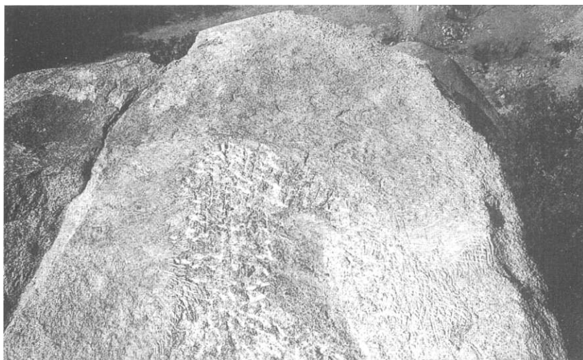
Foto 6. Tercera fase de la reposició: amb una serra radial es retoca la superfície sobre la qual s'ha de recolzar la pedra. Fotografia de Josep Vidal.
