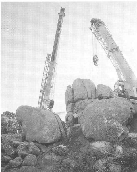
Foto 7. Quarta fase del projecte de reposició: posició de les grues al voltant de la torre rocallosa. Fotografia de Josep Vidal.
