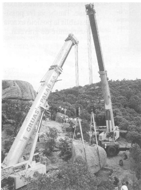
Foto 3. Segona fase de la reposició: una vegada subjectat el bloc amb les eslingues i les gases transversals, es comença a aixecar la roca.
