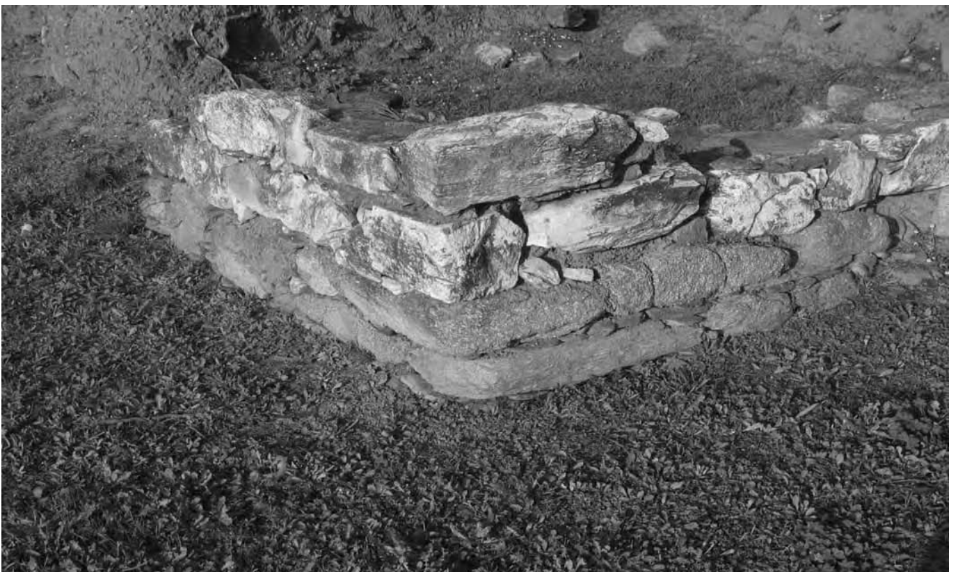
Figura 10.7. Vista del parament de l'angle sud-oest de l'illa I, en la qual s'aprecia un parament ordenat en filades que, a la part superior, utilitza unes pedres excepcionals en el conjunt del barri (foto AM. Puig)
