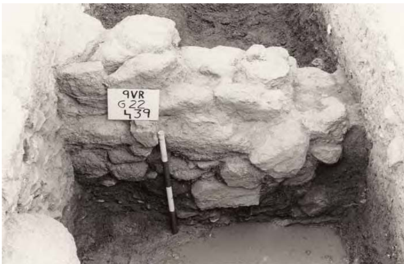
Figura 10.21. i 10.22. Planta i alçat del mur que forma part del moll hel·lenístic, descobert en el subsòl de l'habitació H-XXII de l'edifici A (foto F.X. Nieto)
