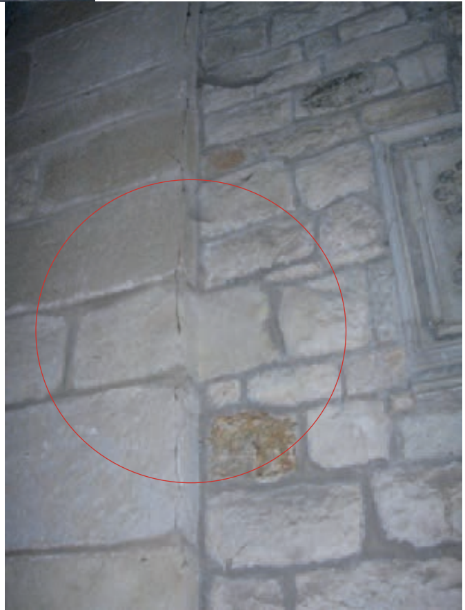
Fig. 152. Torre de Carlemany. Detalls de la imbricació de blocs de pedra sorrenca en els reforços laterals dins els paraments de macs de pedra calcària.
