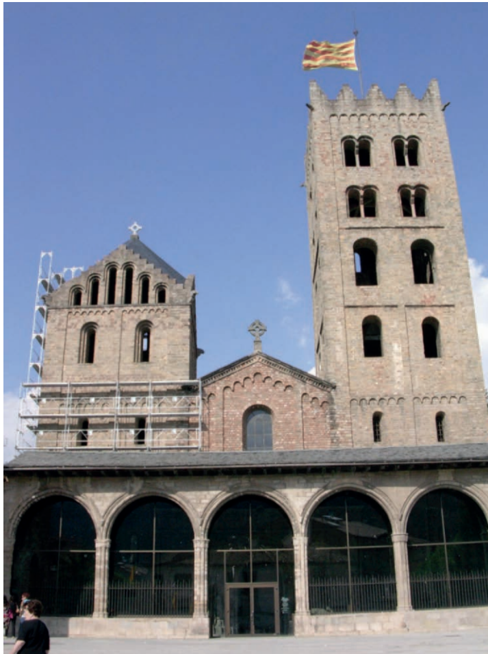
Fig. 53. Aspecte actual de la façana de Santa Maria de Ripoll.
