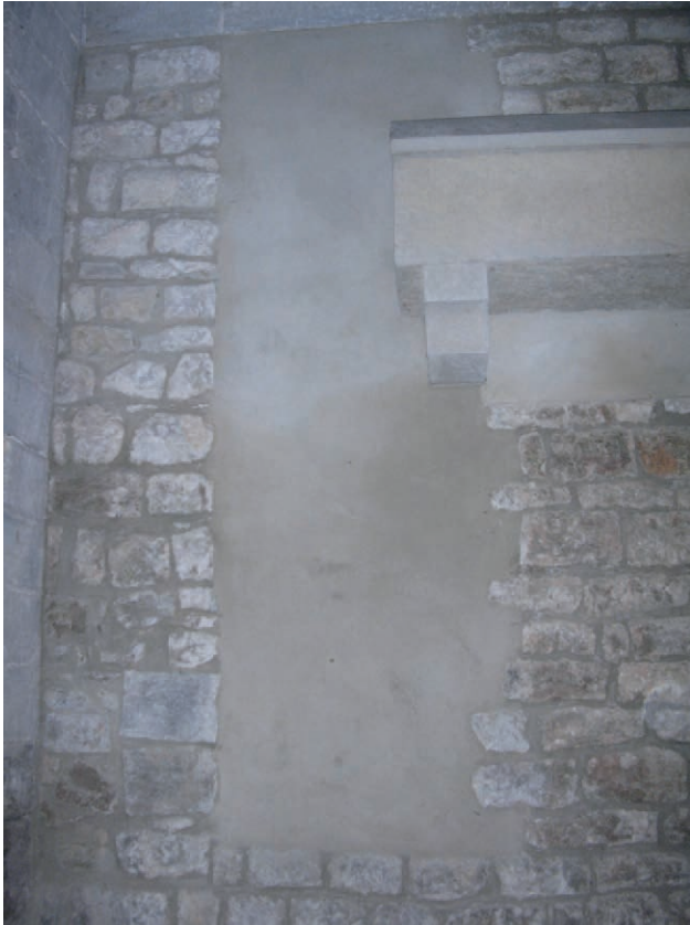
Fig. 93. Possibles restes d'una antiga obertura al mur est de la Torre de Carlemany (capella de Sant Rafael).
