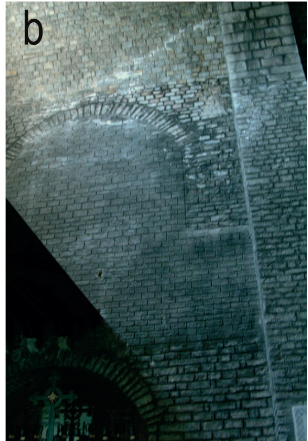
Fig. 55. Restes d'arcs antigament oberts a la tribuna alta del cos occidental de Santa Maria de Ripoll, paredats durant la restauració vuit-centista; a) mur sud, b) mur nord.
