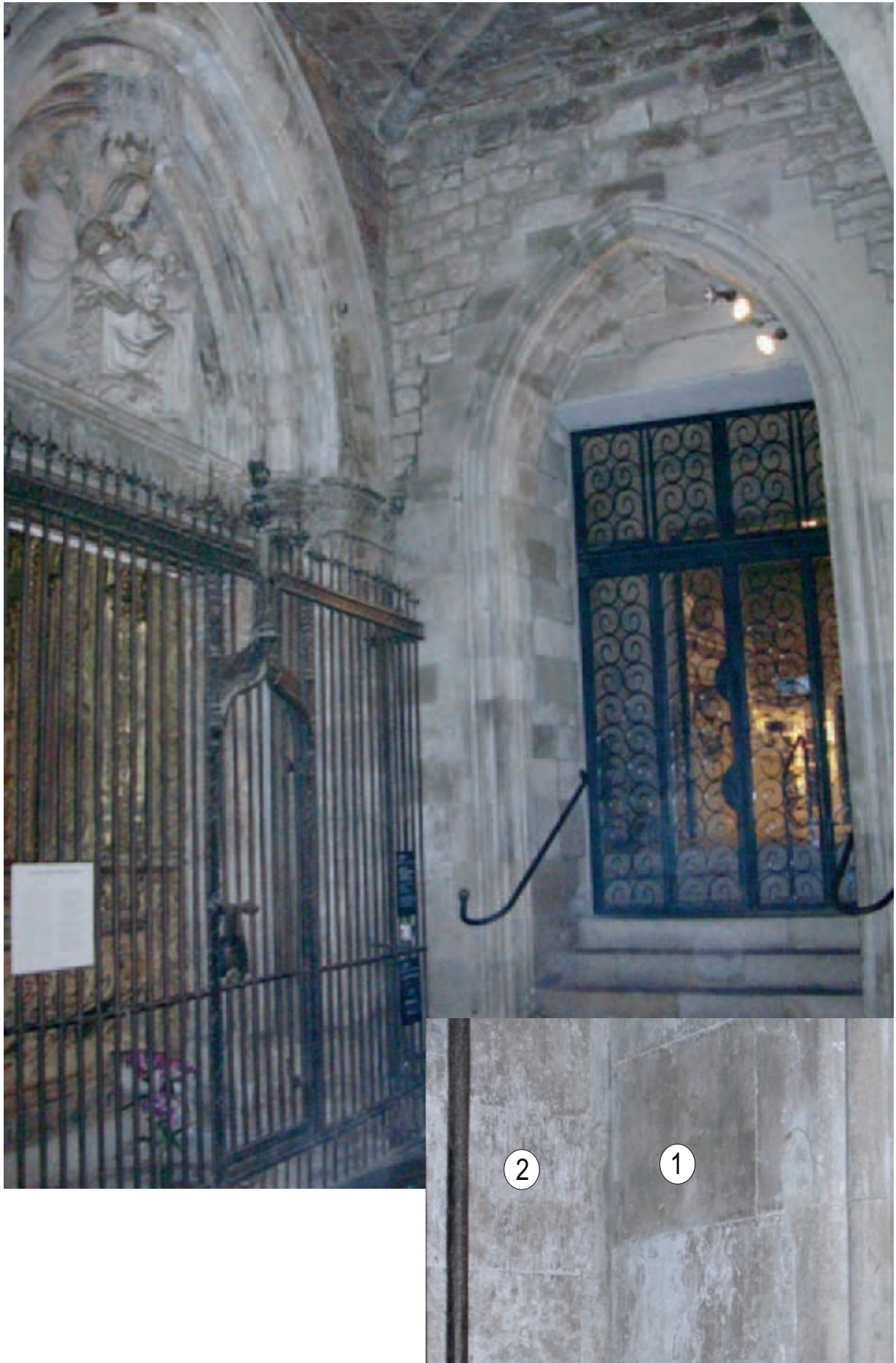
Fig. 230. Angle format per la capella de Bell-ull i l'accés actual al claustre. Detall de les relacions estratigràfiques entre els dos murs del segle XIII: 1) mur anterior (accés actual); 2) mur posterior (Bell-ull).
