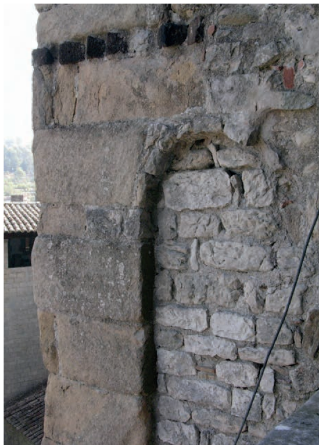
Fig. 94b. Torre de Carlemany, angle nord-oest. Mostra dels diferents materials constructius.
