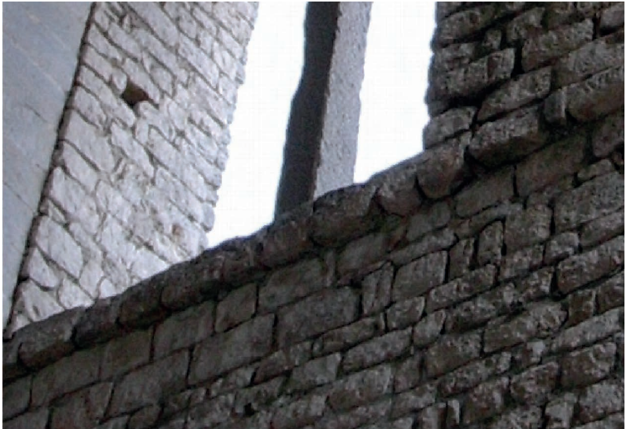
Fig. 96. Interior de la Torre de Carlemany. Detall de la repisa a nivell del cinquè pis.
