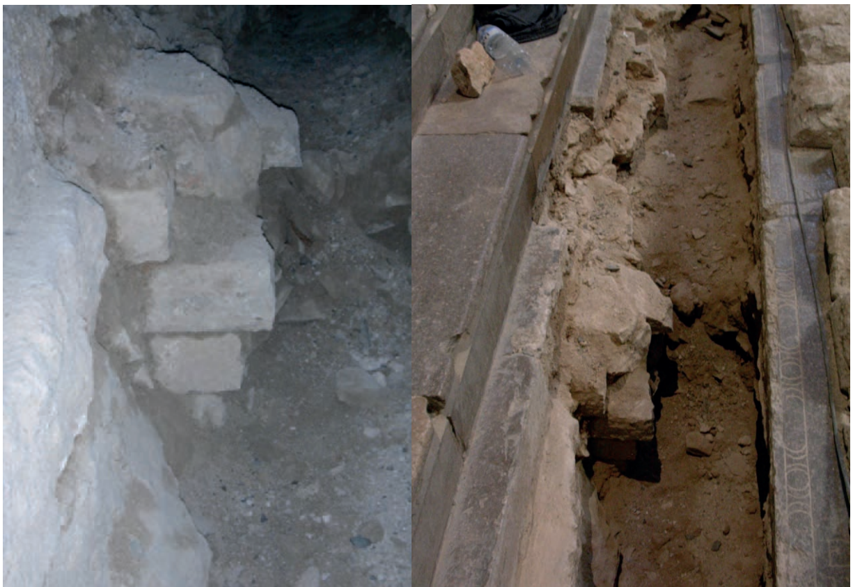
Fig. 86a. Vistes de les restes del mur oriental del baptisteri detectades en el seguiment de 2004, des de ponent (Sureda 2006).
