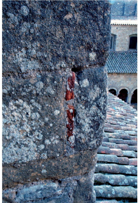
Fig. 94a. Fragments de tegula integrats en els primers nivells de la Torre de Carlemany (angle nord-est).
