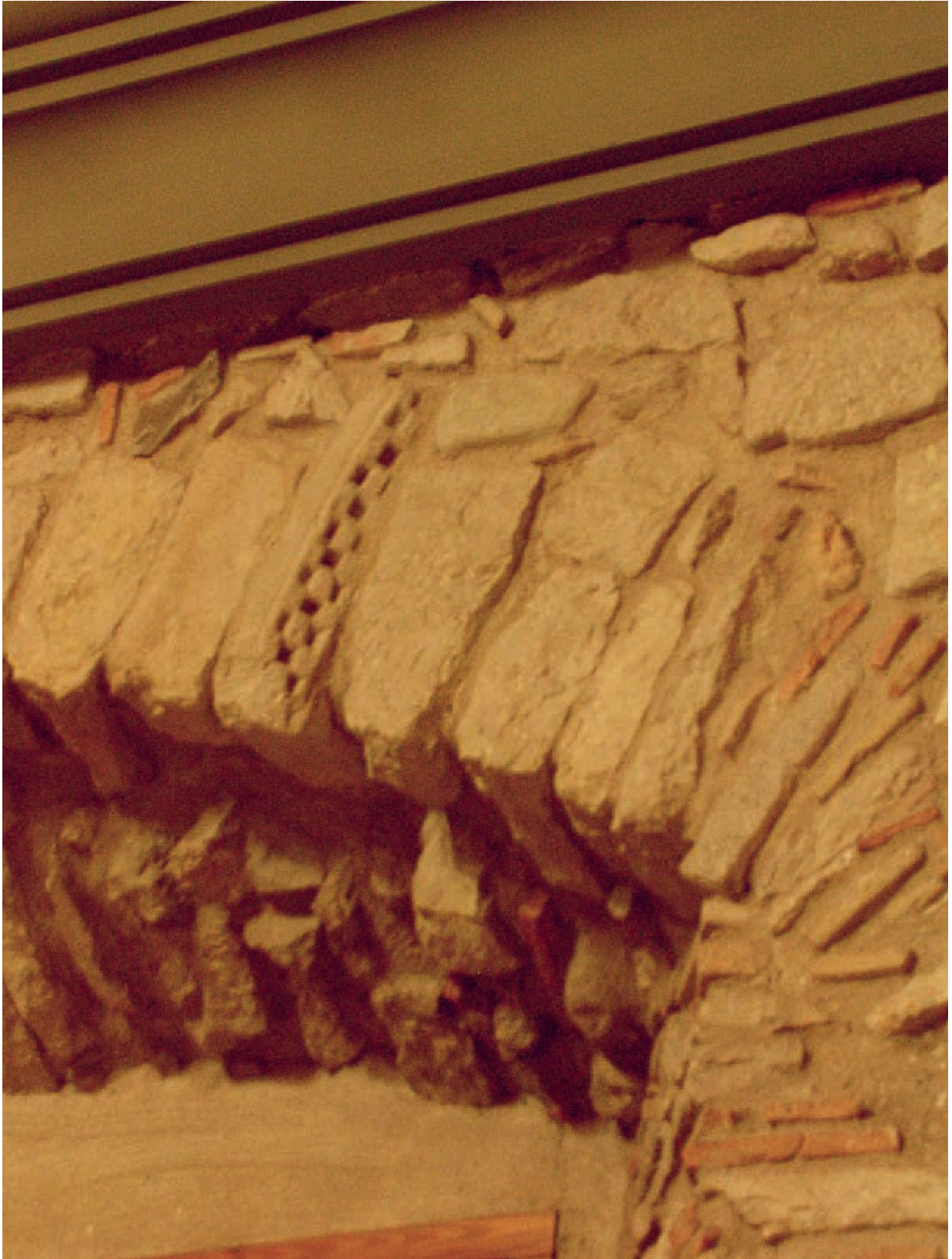
Fig. 170. Fragment d'antiga arquivolta amb decoració escacada, probablement de la Galilea, inclosa al mur oest de la primera Sala Capitular (1705-1728).
