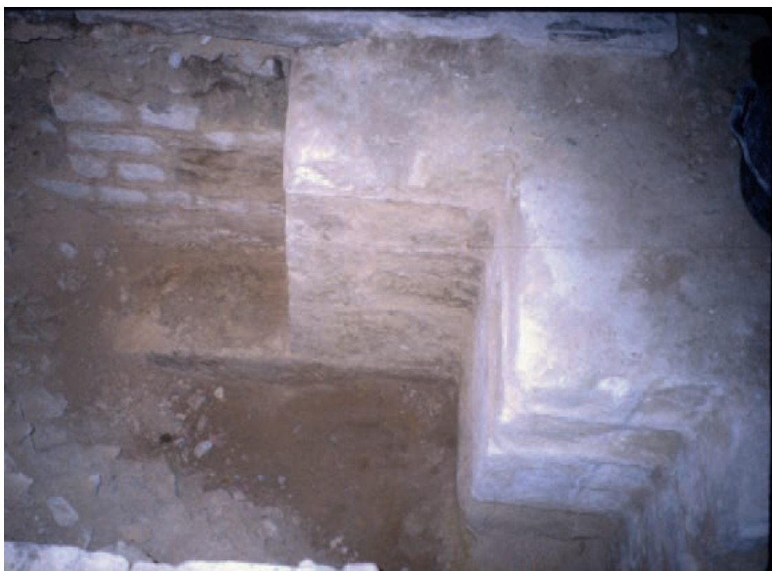
Fig. 40f. Detall de la tècnica constructiva del pòrtic. Angle dels murs u.e. 1046 (dreta) i 1055 (esquerra). Mur 1055: combinació de filades de macs de calcària desbastats amb les juntes ben marcades amb banqueteta d'arcosoli de sorrenca. Angle: blocs de pedra sorrenca ben escairats i rejuntats .
