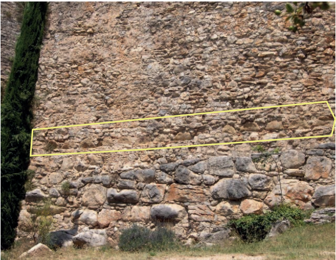
Fig. 25. Possibles semitambors de columnes conservats a la Muralla de les Àligues, inclosos en les reformes d'època carolíngia.
