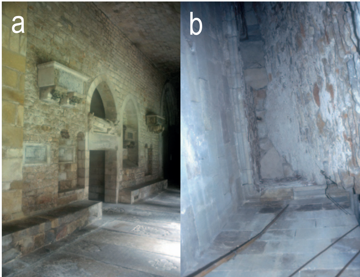
Fig. 215: a) façana de l'antiga sala capitular, des de llevant; b) restes de la volta de canó que cobria la sala capitular, engolida per la construcció gòtica
