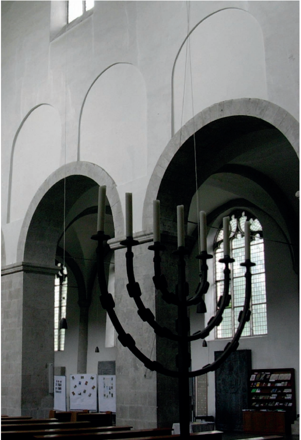
Fig. 165. Sant Pantaleó de Colònia. Restes de les arcades murals de la nau única de finals del segle X a l'interior del mur sud de la nau central actual.
