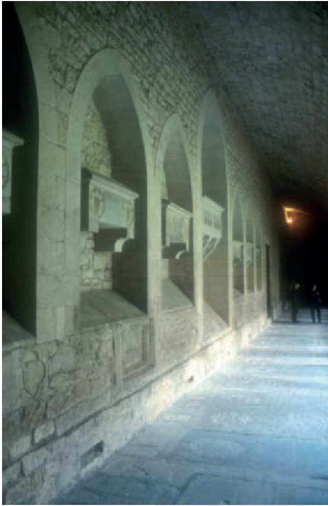
Fig. 208h. Arcosolis neogòtics a l'exterior del mur est (galeria claustral).
