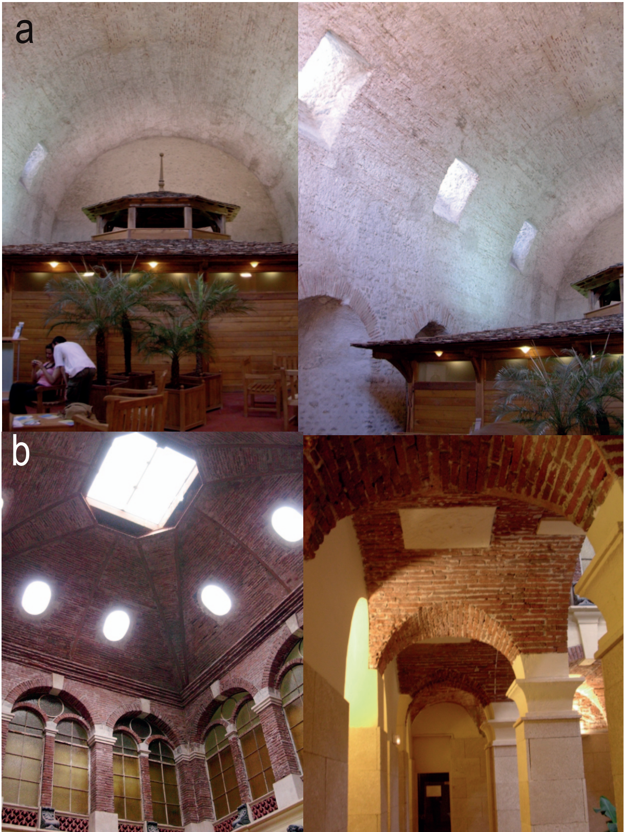
Fig. 116. Termes romanes d'Els Banys d'Arles (Vallespir): a) Basilica thermarum , b) cambra coberta amb voltes de rajol.
