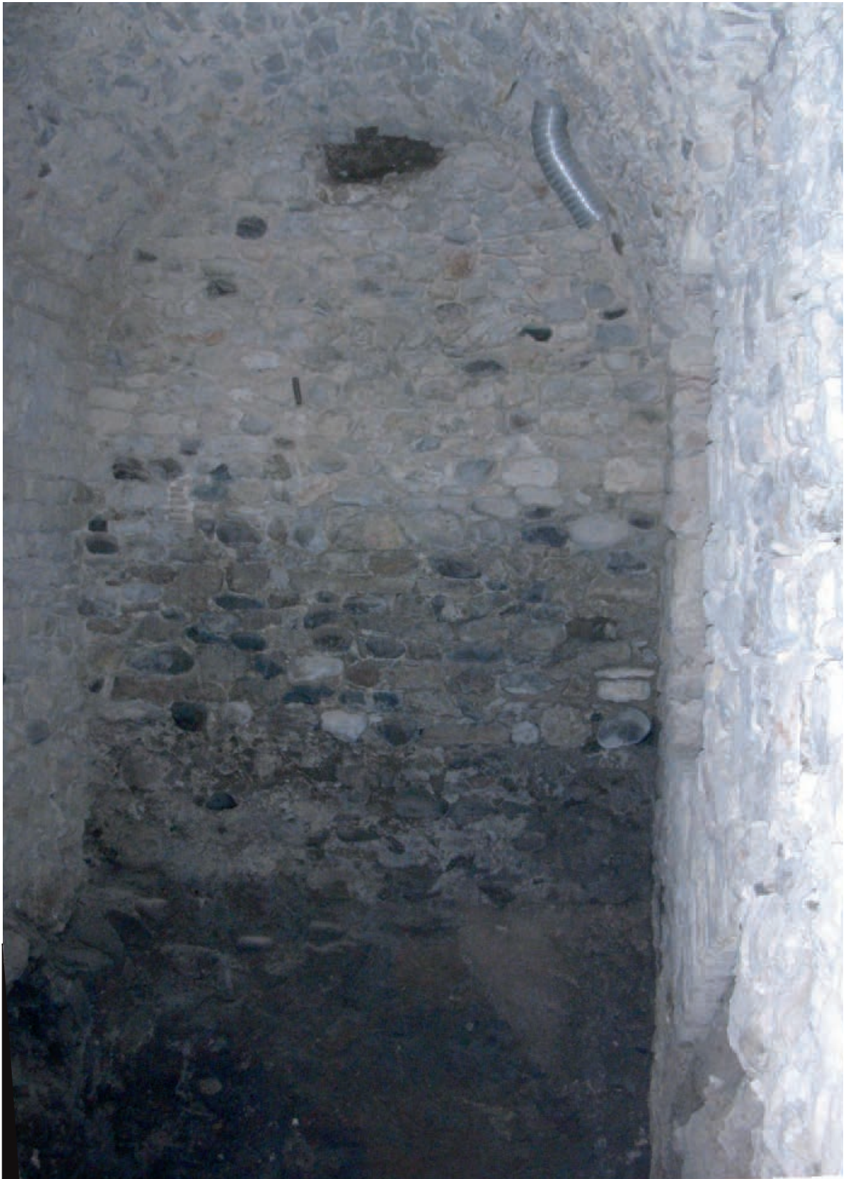
Fig. 213. Interior de la cambra nord-occidental, des del nord. Al fons, mur de tanca segurament d'època moderna; la seva posterioritat s'aprecia al capdamunt de la volta.
