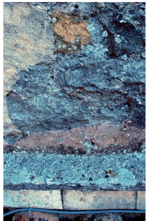
Fig. 95. Restes de revestiment dels murs de la torre al contacte amb la teulada de la galeria claustral sud.
