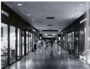
Mies van der Rohe. Toronto Dominion Center , 1963-1969.
