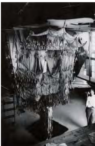
Antoni Gaudí. Maqueta funicular fotografiada en la posició original, 1898-1904.
