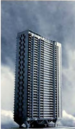
Antoni Bonet Castellana. Edifici d'habitatges T.O.S.A. , 1952.
