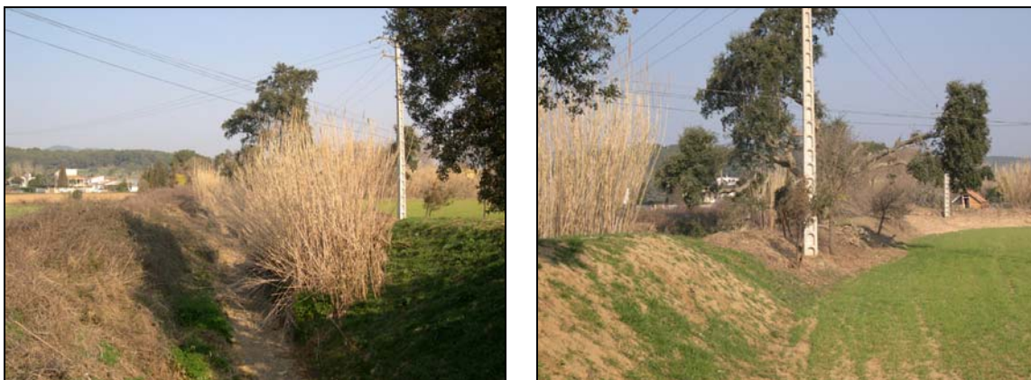
Figura 9.12.- Construcció de marges artificials. Exemple de la riera de l'Aubi
