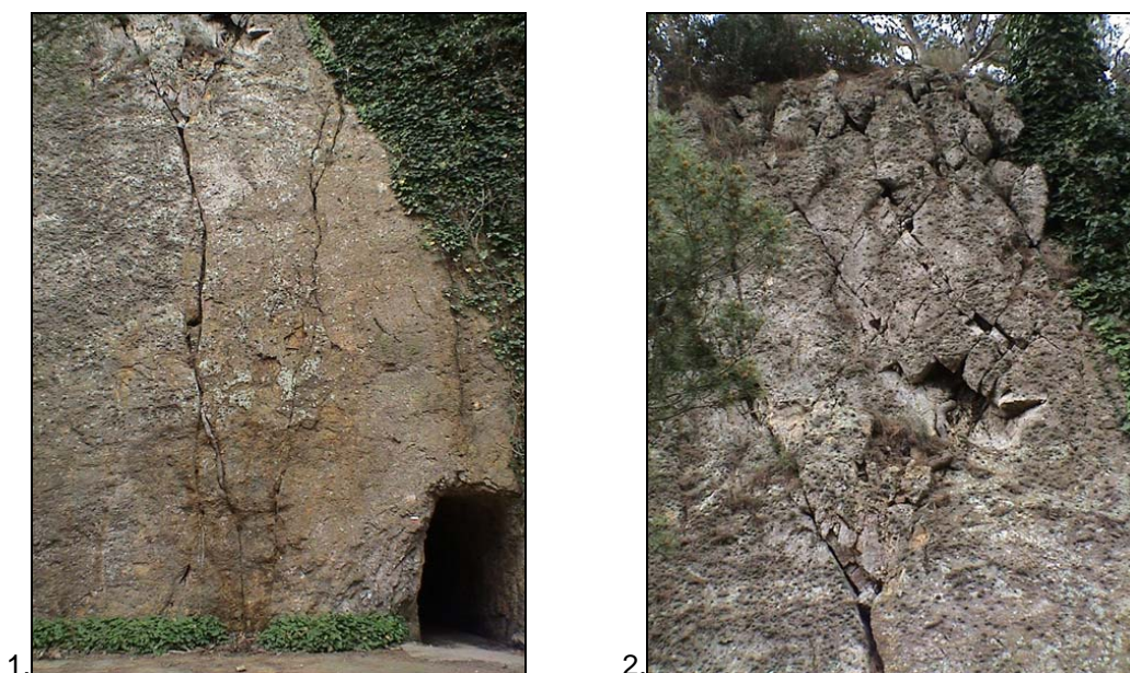
Figura 12.7.- Camí de ronda de Calella, sector 4 (1.- visió general; 2.- detall dels blocs inestables (març de 2004)
