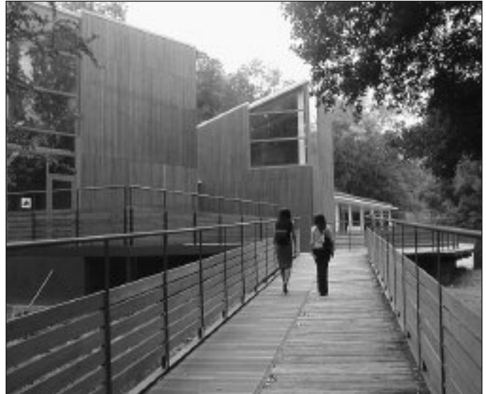
Fig. 8. Acceso al parque y edificio de recepción. Al fondo, el área de actividades (foto Consell Comarcal del Pla de l'Estany ) Fig. 8. Acces to the park and reception building. In the background, the activity area can be seen. (Photograph by Consell Comarcal de Pla de l'Estany)
