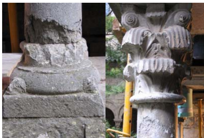
Fig.8 Vista detall de la base i el capitell d'una columna del claustre
