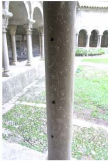
Fig. 9 Vista detall de l'estat de desgast d'una columna del Claustre
