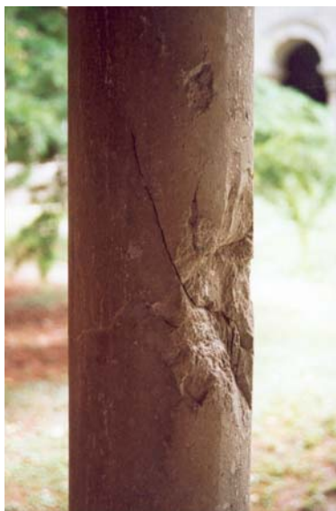
Fig. 7 Vista detall d'una important fisura en una columna
