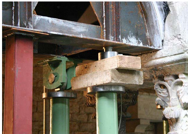
Fig. 20 Foto de la cèl·lula de càrrega col·locada en un dels puntals hidràulics
