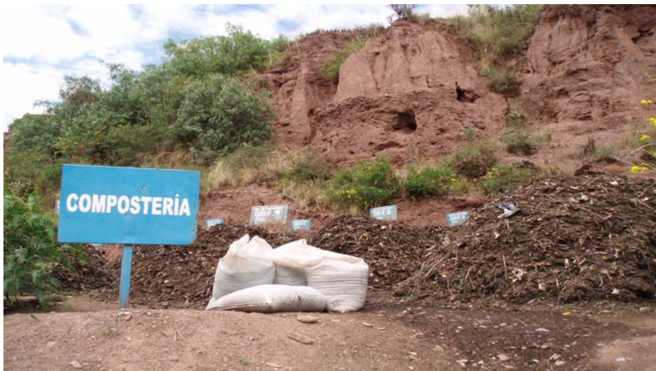
Figura 4.21 Planta de Tratamiento de Rayallaqta
