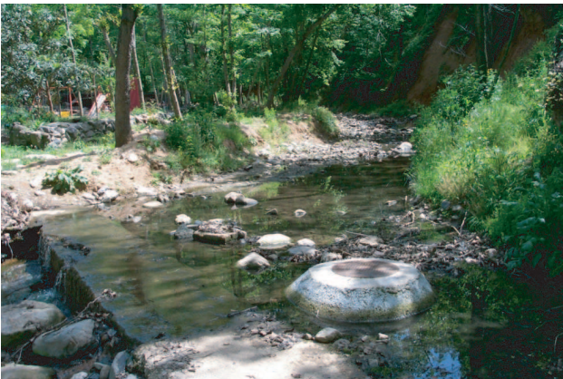
4i) estructura sòlida (tapa del col·lector) al llit del riu
