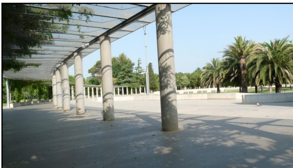
Figura 22 : Parc del Migdia/Casernes. Vista de la rotonda interior en forma de mitja lluna.
