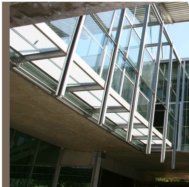
Connexió entre els dos mòduls de la biblioteca de Montilivi
