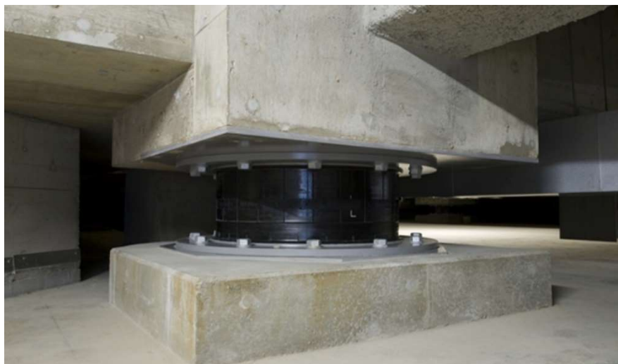
Figura A.2. Aïllador sísmic en edifici
