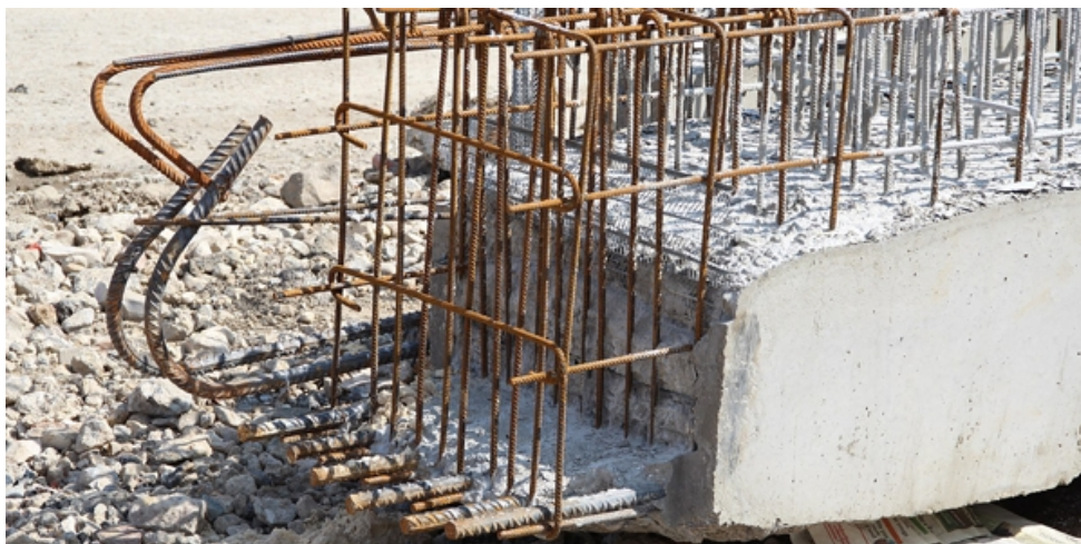
Figura 1: El formigó armat és un exemple d'estructura MM, que combina formigó amb reforç intern de barres d'acer. Font [1]
